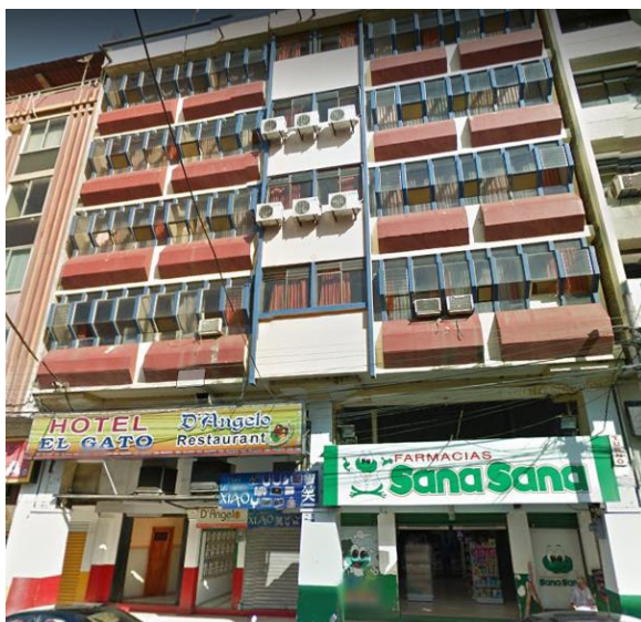
Ilustración 5. Hotel El Gato antes del sismo.
