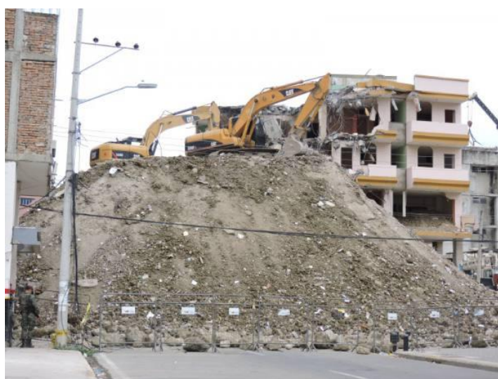
Ilustración 4. En proceso de demolición del Hotel New York después del sismo.
