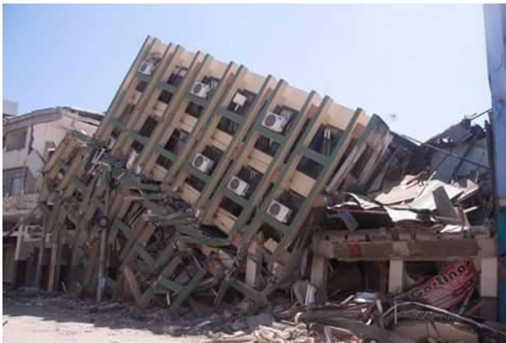
Ilustración 16. Cooperativa del Magisterio Manabita colapsado. (Fuente: Ing. Alex Villacrés)
