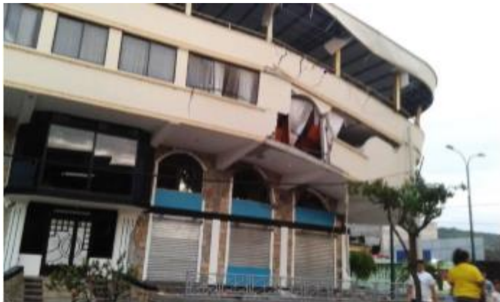
Ilustración 25. Edificio Sr. Pedro Ramírez. (Fuente: Ing. Roberto Aguiar y Ing.Jordy Mieles)
