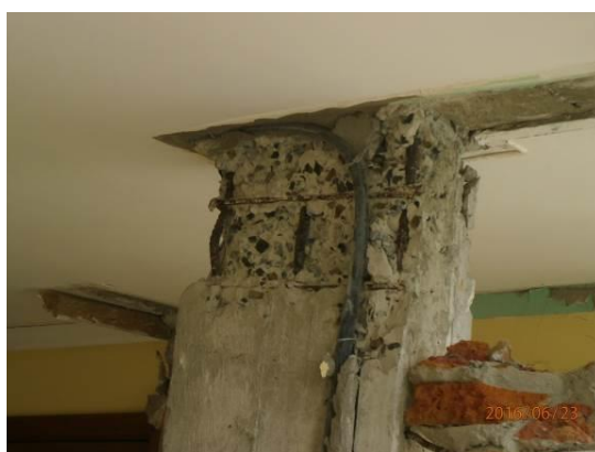
Ilustración 50 Desprendimiento de recubrimiento en la conexión y corte en mampostería
