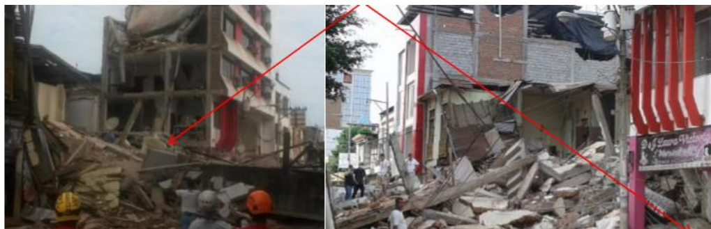
Ilustración 18. Edificio Capitana Santa después del sismo. (Fuente: Ing. Roberto Aguiar y Ing. Jordy Mieles)
