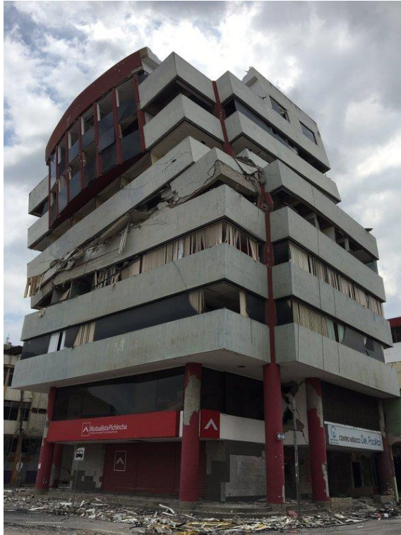
Ilustración 14. Edificio Centro Médico el Pacífico después del sismo. (Fuente: Tatiana Hidrovo)
