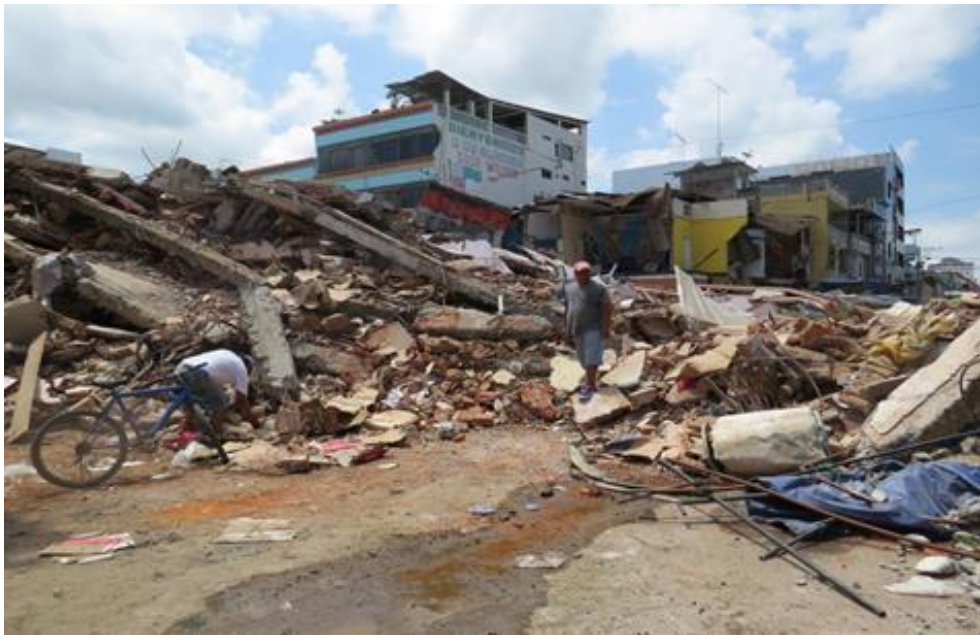
Ilustración 24. Edificio Calzado Mariner después del sismo. (Fuente: Ing. Roberto Aguiar y Ing.Jordy Mieles)
