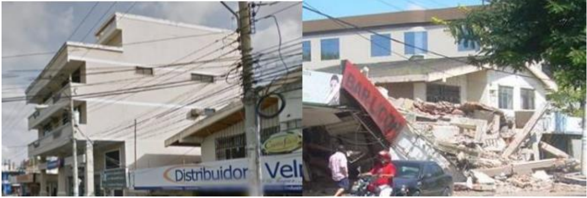
Ilustración 26. Edificio Servipagos (Fuente: Ing. Roberto Aguiar y Ing. Jordy Mieles)
