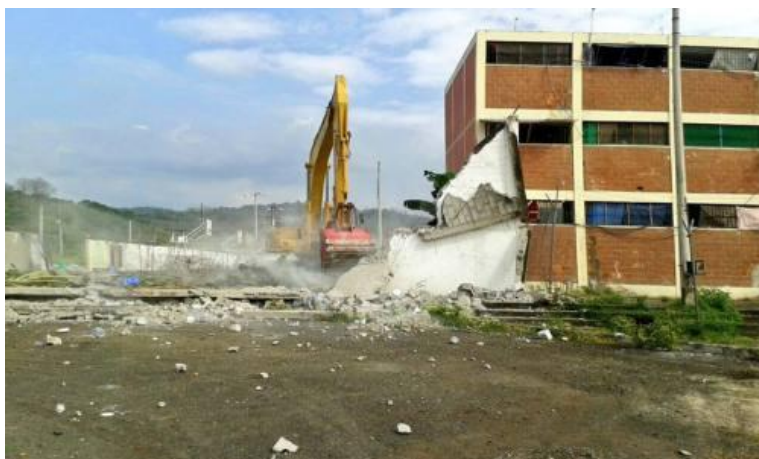
Ilustración 1. Centro de Rehabilitación Social del Rodeo después del sismo.
