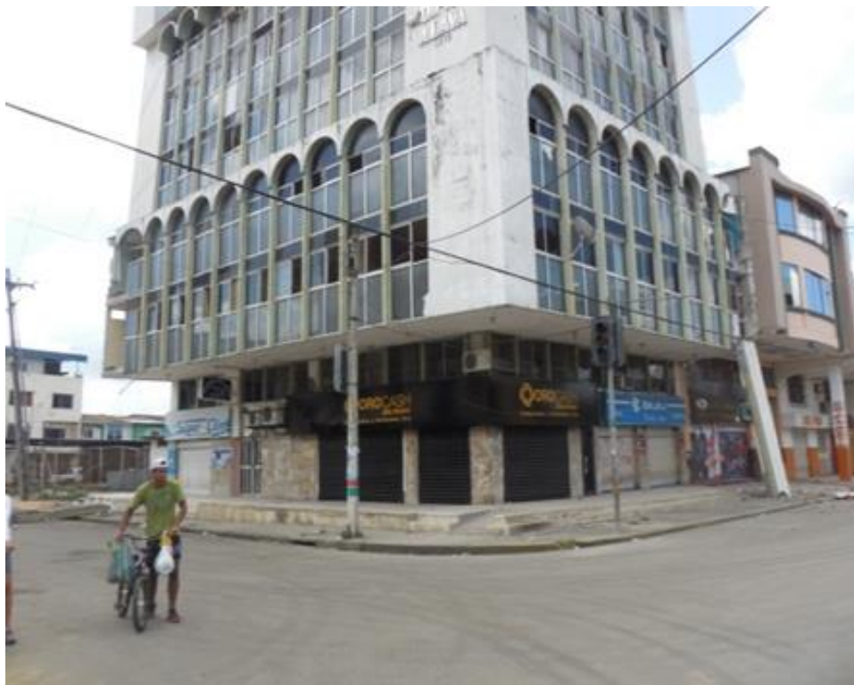
Ilustración 9. Edificio Álava después del sismo. (Fuente: Ing. Hugo Landívar)
