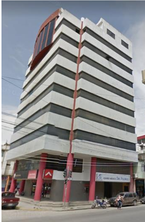
Ilustración 13. Centro Médico del Pacífico antes del sismo. (Fuente: Google Maps)
