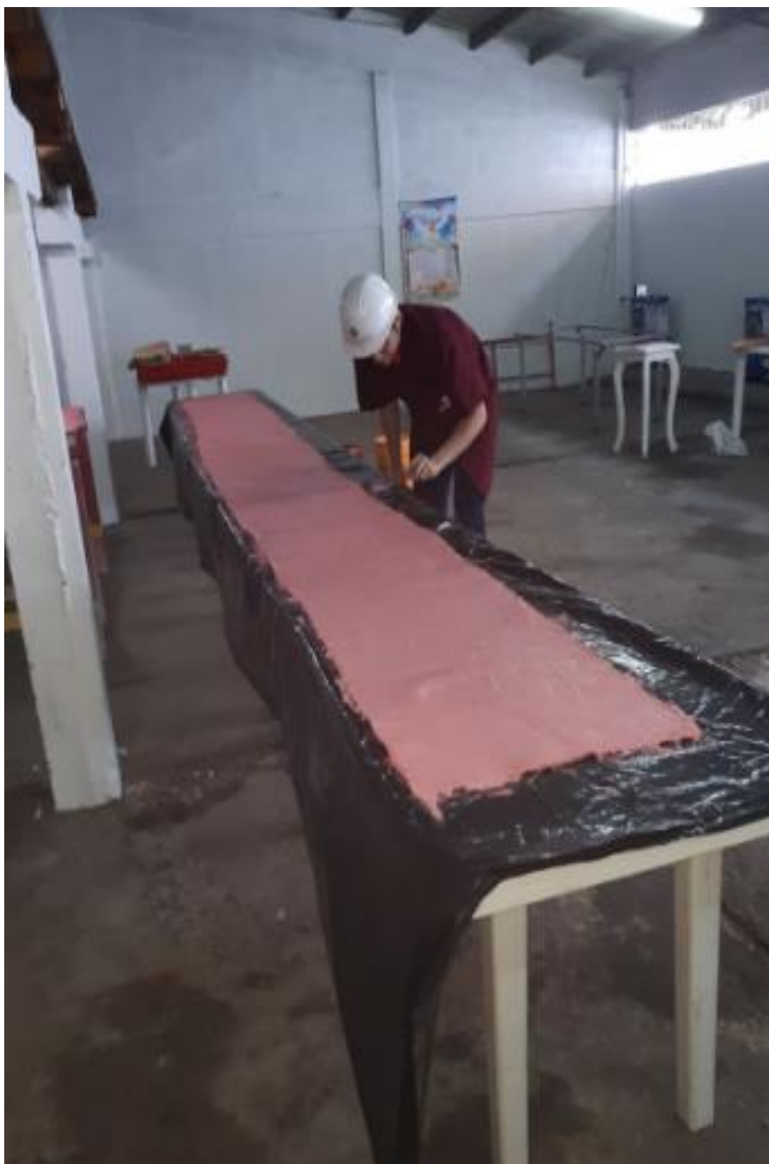
Figura 58. Verificación del espesor en la manta impermeabilizante natural.
