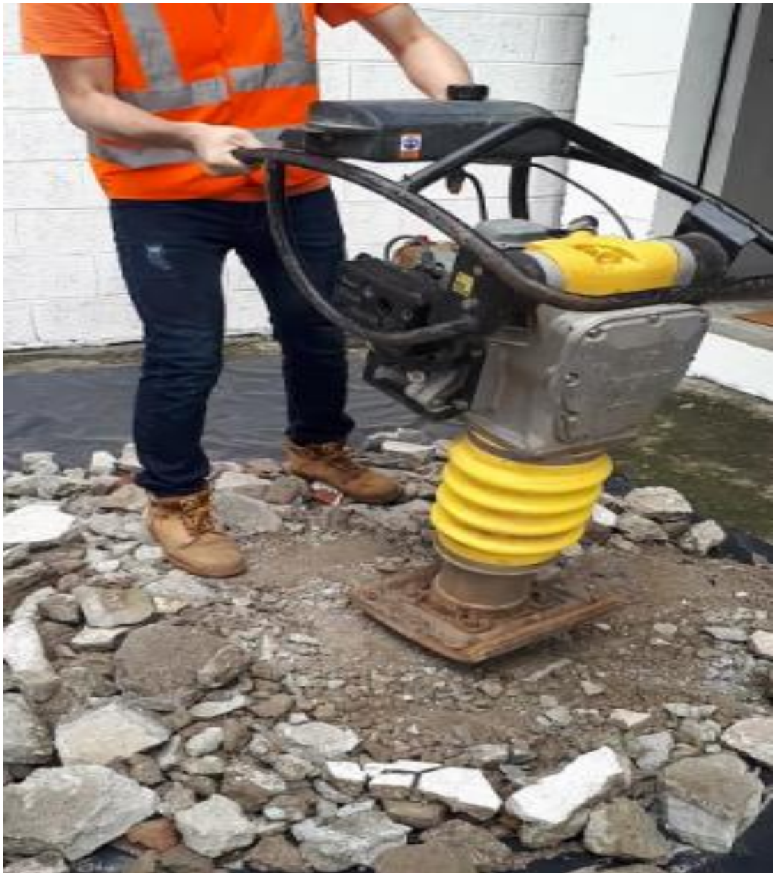
Figura 30 Trituración del material con Vibropisonador.
