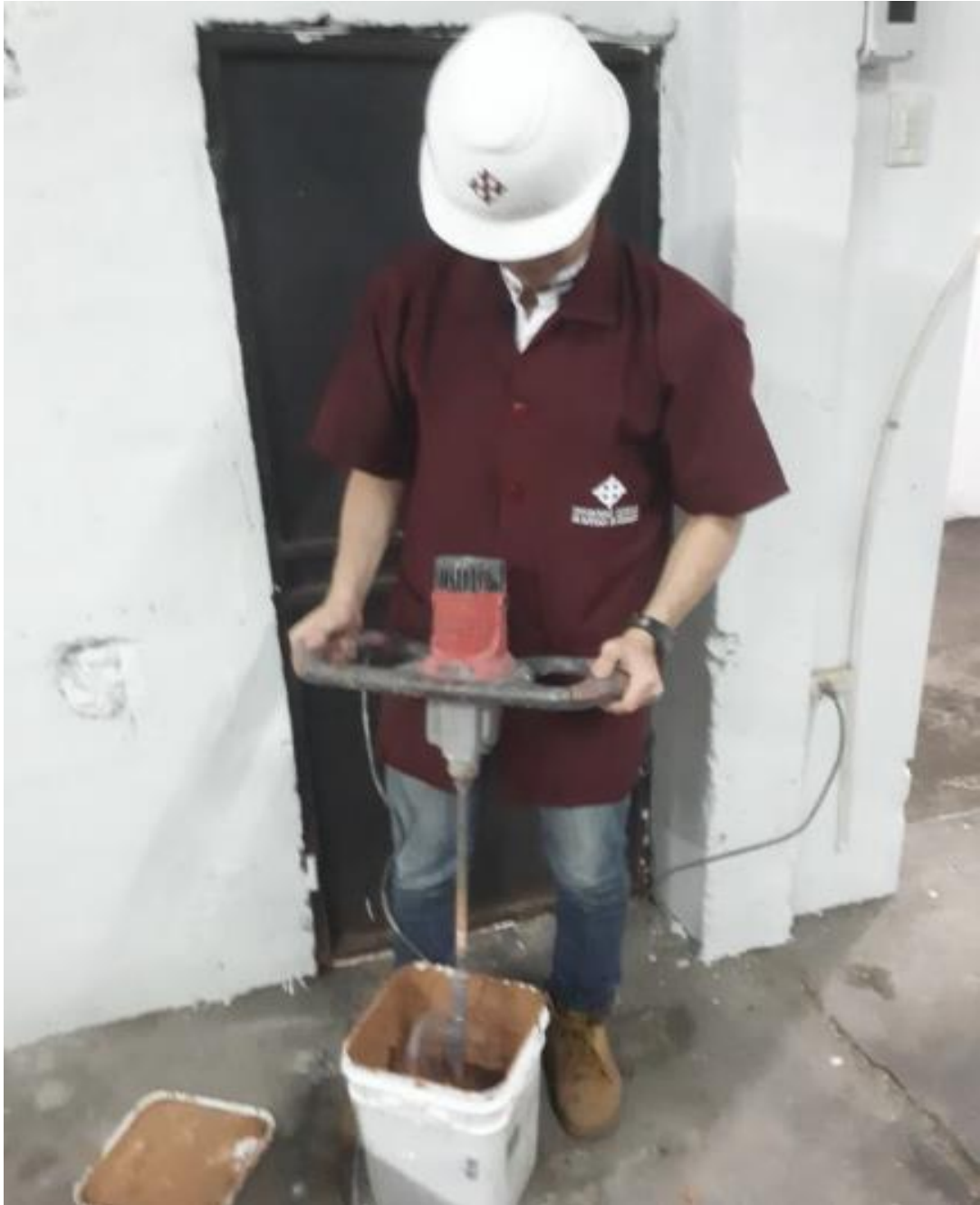
Figura 53. Mezclado del material con taladro rotatorio.
