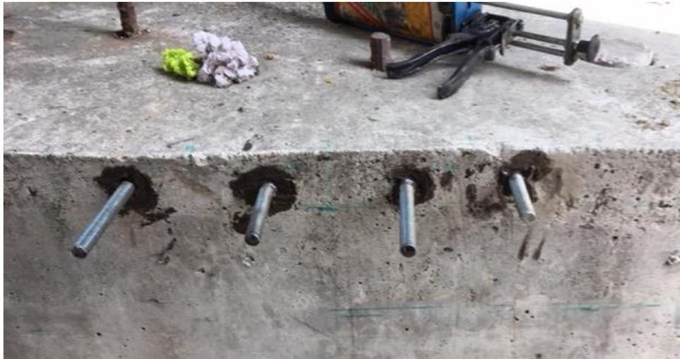
*Ilustración 11.* Los últimos 4 anclajes químicos instalados.
