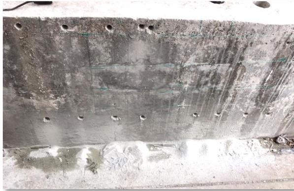
**Ilustración 9.** Distribución de las perforaciones para los anclajes químicos.
