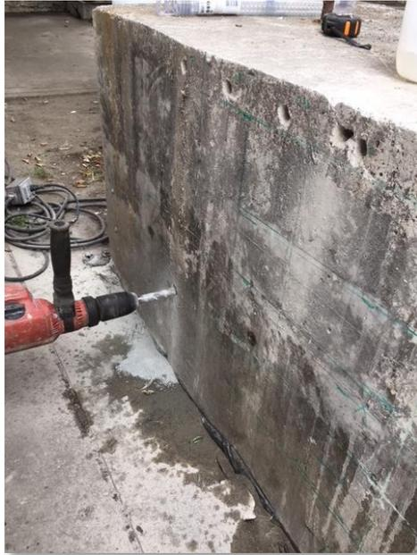
**Ilustración 7.** Realización de perforaciones con taladro roto-percutor.
