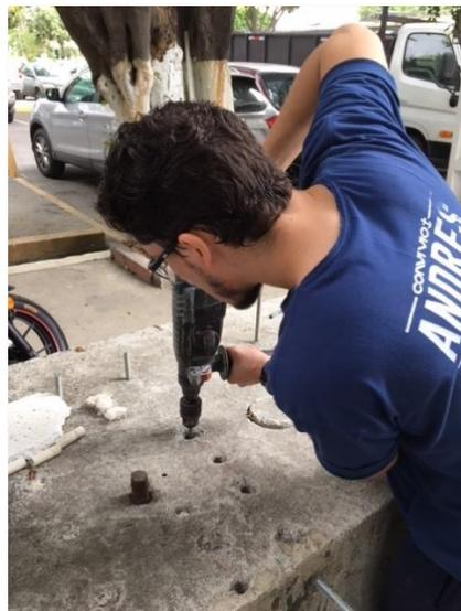
**Ilustración 13.** Perforaciones en el acero descubierto.
