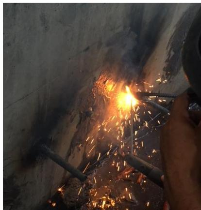
***Ilustración 23.*** Proceso de soldadura de los tramos cortados de las varillas de los anclajes químicos.
