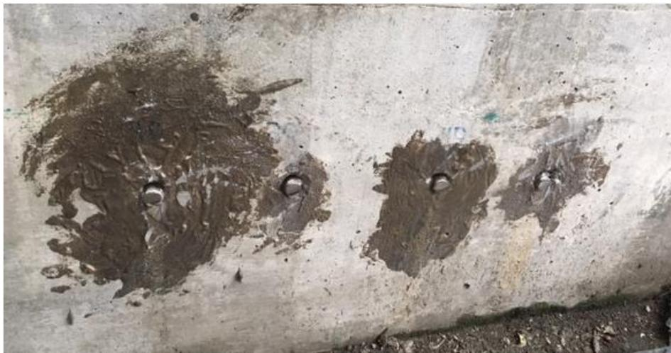
*Ilustración 34.* Grupo de varillas sin soldar, pulidas.
