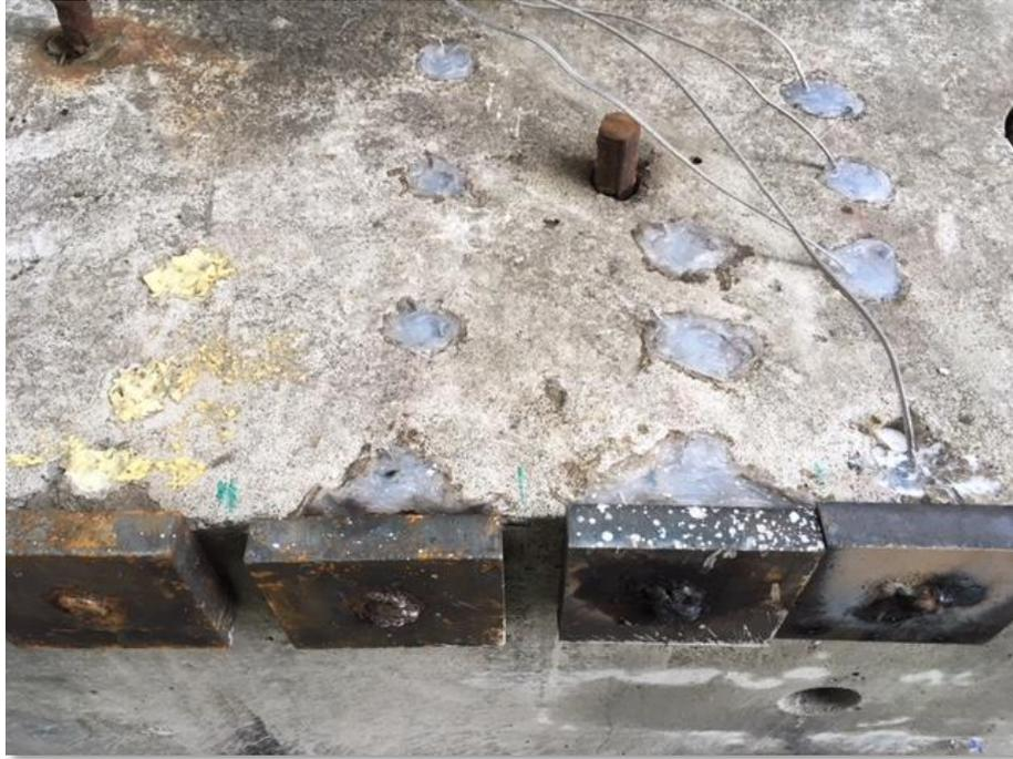
*Ilustración 22.* Proceso de soldadura de placas y medición de temperatura terminado.
