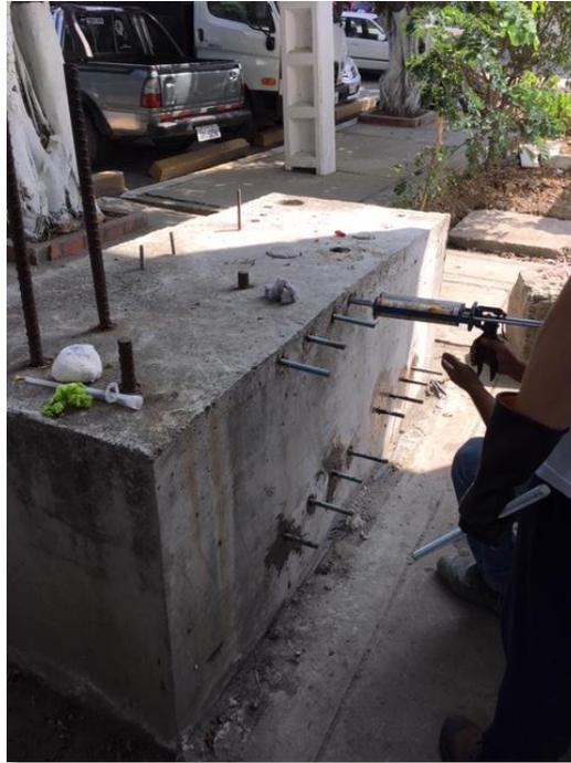
*Ilustración 10.* Finalización de la instalación de los anclajes químicos.
