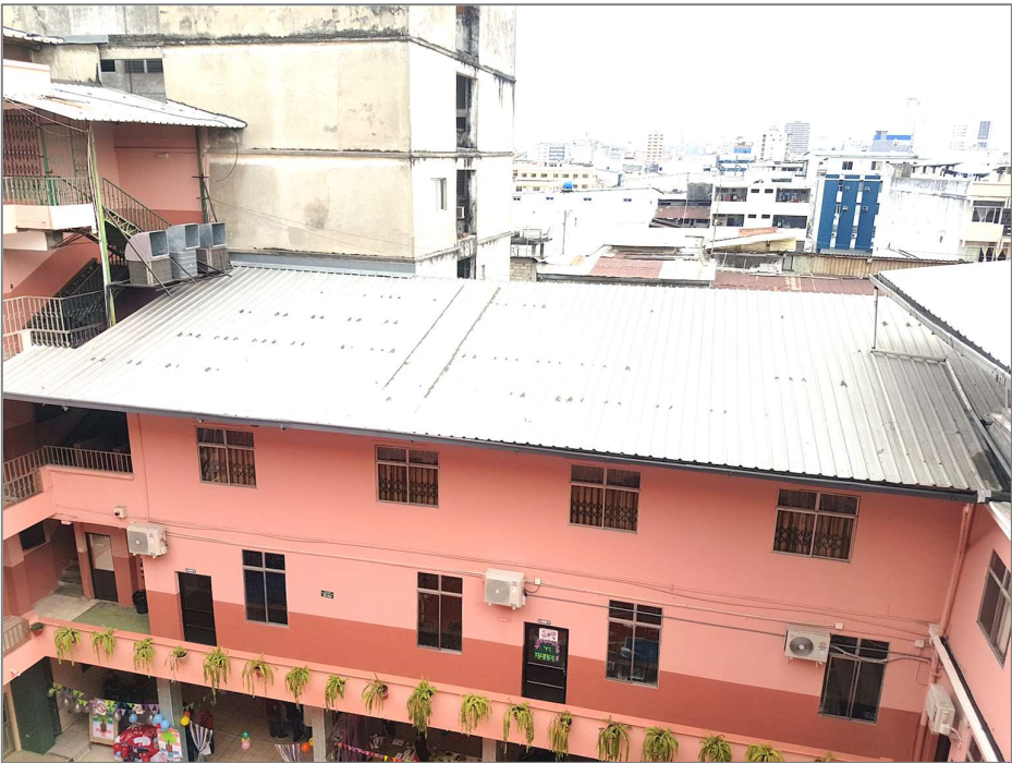
Vista General del Ala Norte
