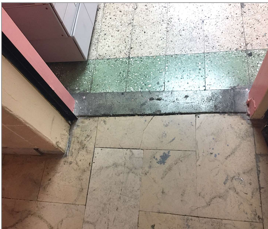
Junta de Construcción del Ala Este – entrada de la Biblioteca – Segundo Piso
