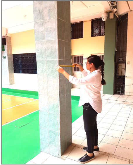
Medición de la columna en Planta Baja
