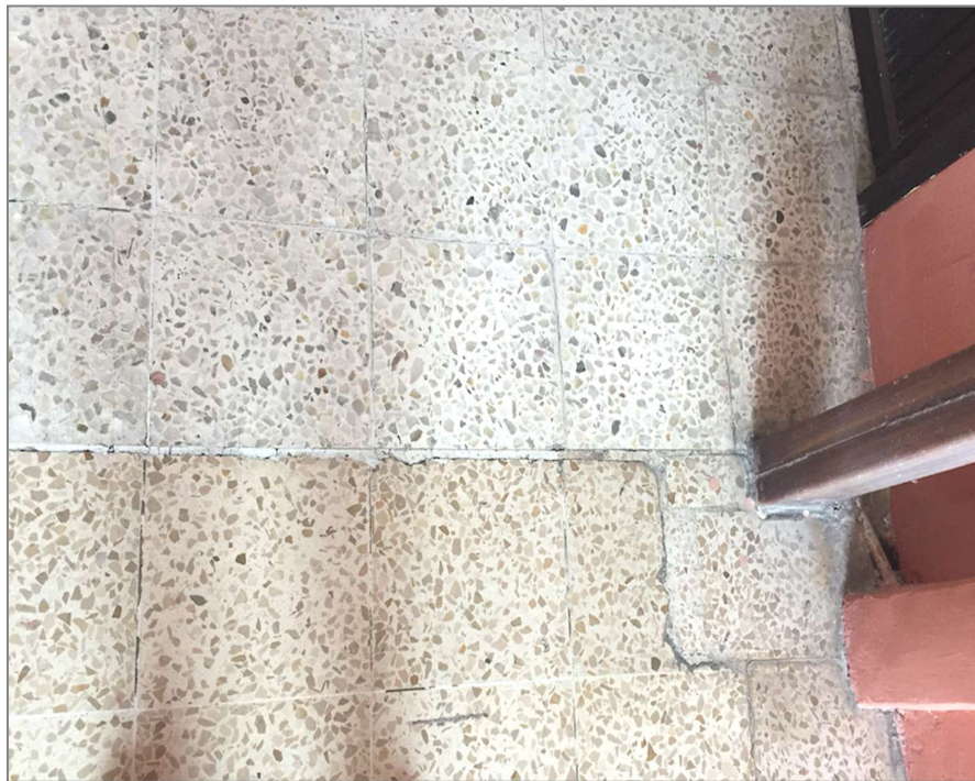
Junta de Construcción del Ala Este – Tercer Piso
