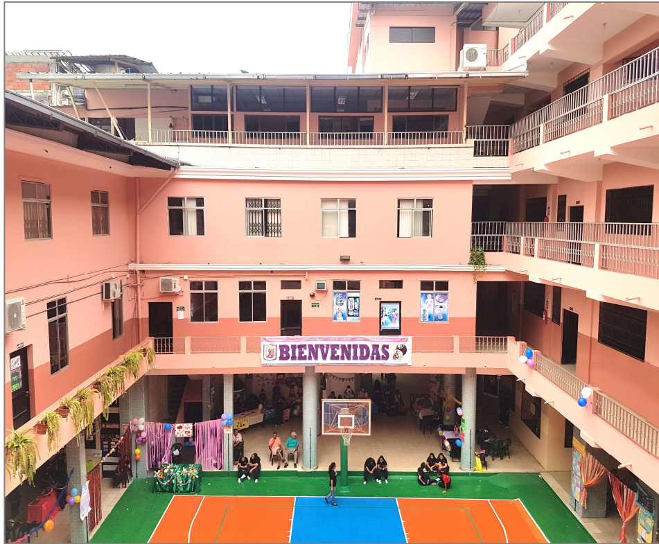
Vista General del Ala Este
