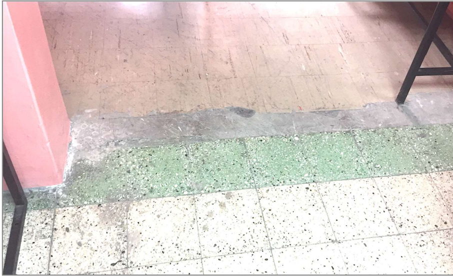
Junta de Construcción del Ala Este – interior de la Biblioteca – Segundo Piso
