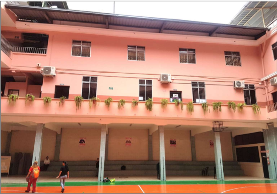
Vista General del Ala Norte
