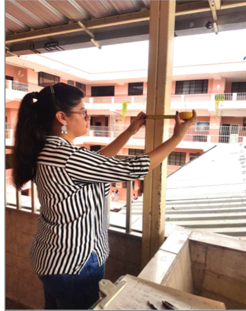
Medición de la columna - Tercer Piso
