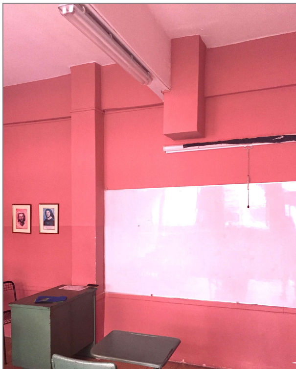
Ejes verticales discontinuos o muros soportados por columnas en Primer Piso - Irregularidad en Elevación
