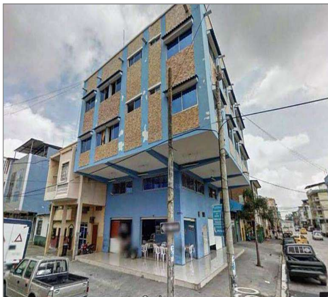
Figura 1. Edificio de la esquina Ayacucho y García Moreno en Guayaquil, antes del evento de 16 de abril de 2016. Fuente: Google Earth
