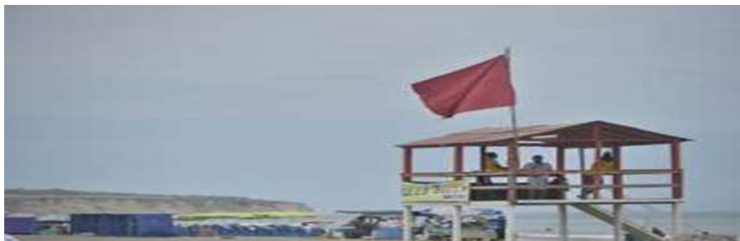
Figura 6. Torre de control de salvavidas dentro del área.
