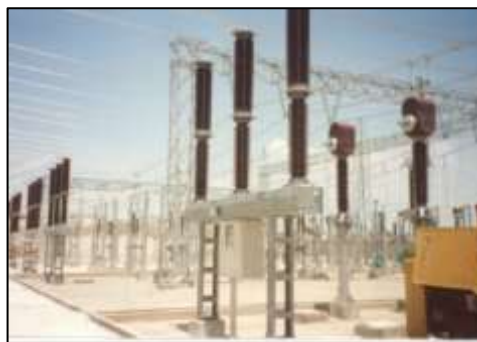
Figura 2.6: Interruptor de Potencia Fuente: (Teoriaelectro, 2018)
