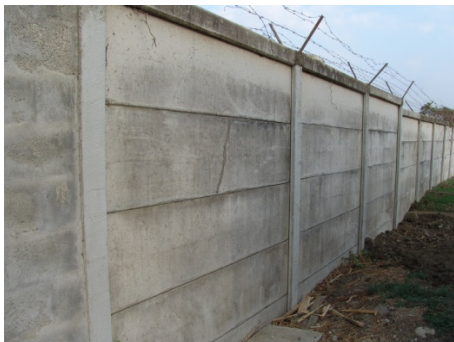
Foto de pared de hormigón prefabricado instalaciones Planta Piloto Ecomateriales - Guayas)
