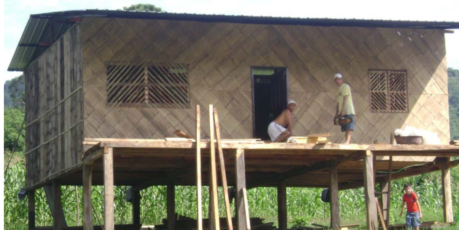
Fotos de Viviendas de Caña Picada en Pachinche-Manabí colocada en forma diagonal, formando figuras geométricas.
