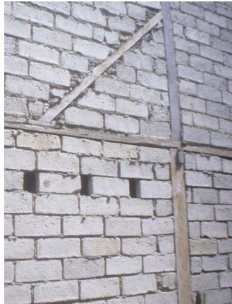
Foto pared mixta de bloque y madera (registros Arq. Jorge Morán)
