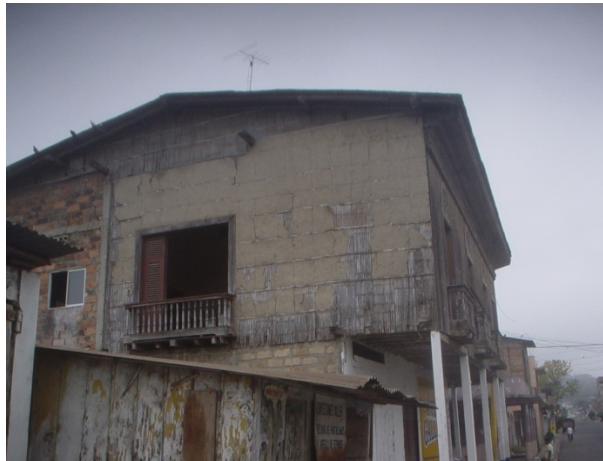
Fotos de Vivienda de Quincha en Manabí
