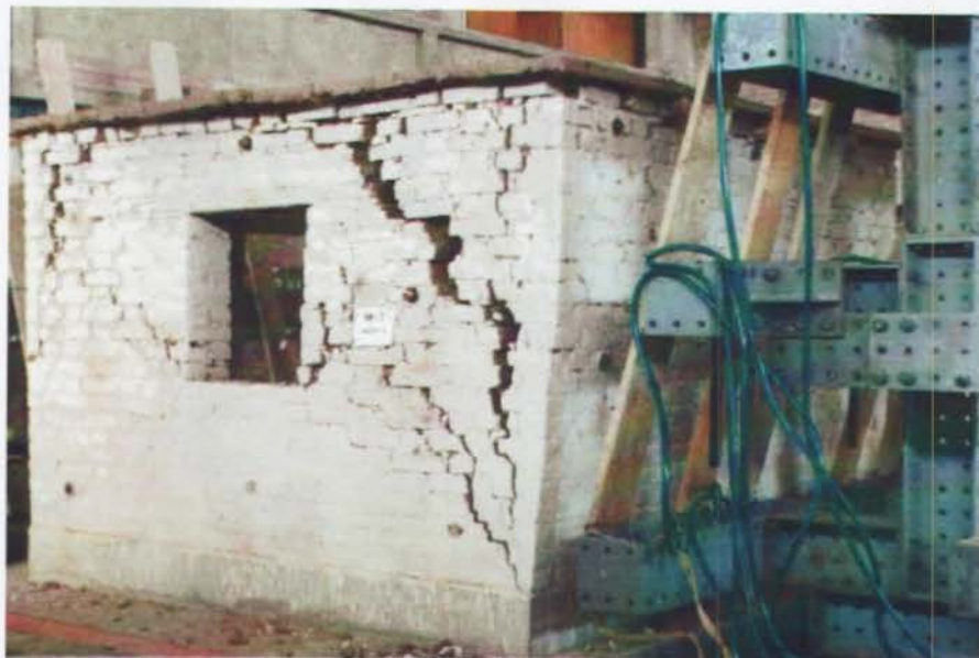
Foto 9. Grietas verticales en esquina, reproducidas en ensayo dinámico en mesa vibradora. Módulo con techo. Foto: LEDI Figura # 25
