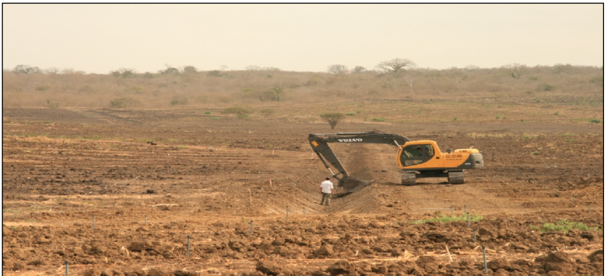
Imagen # 5: Elaboración de drenajes Fuente: Hacienda la Escondida
