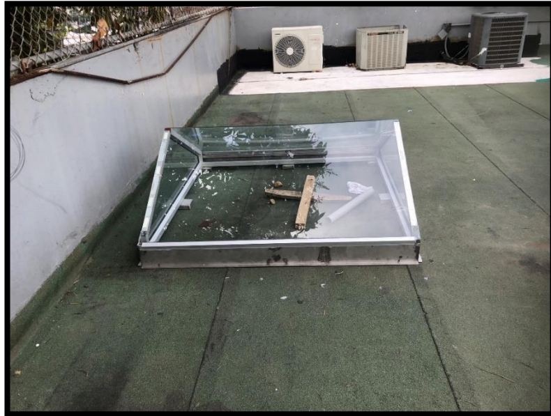
Ilustración 23. Estructura de vidrio.
