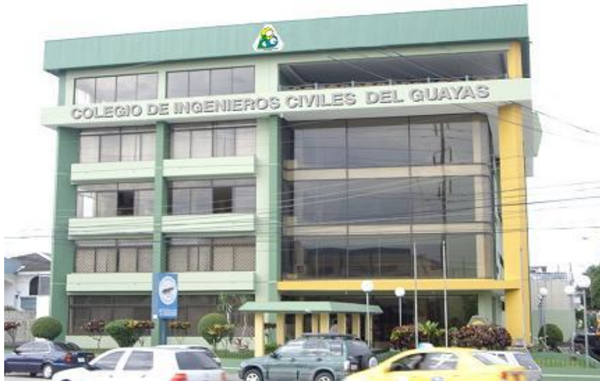
Figura 19. Colegio de Ingenieros Civiles del Guayas – Sede Guayaquil Fuente: Sitio Web del Colegio de Ingeniero Civiles del Ecuador, 2017
