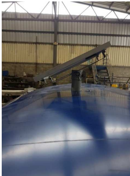
Figura 24. Vista lateral panel solar. Fuente: Elaboración propia.
