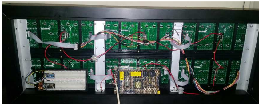
Figura 4. 2. Resultado final del cableado Elaborado por: Autor.
