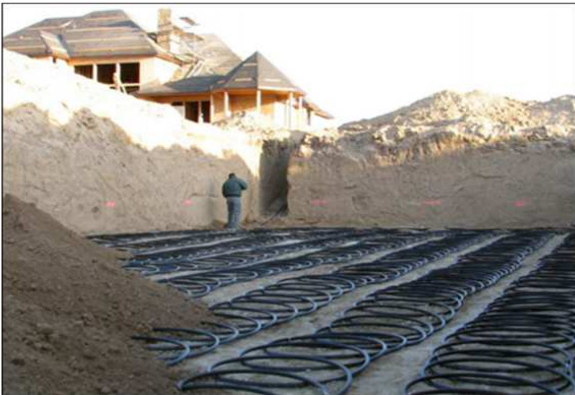
Figura 2.7 Climatización de edificio por medio de energía geotérmica. Fuentes: (INER, 2017)
