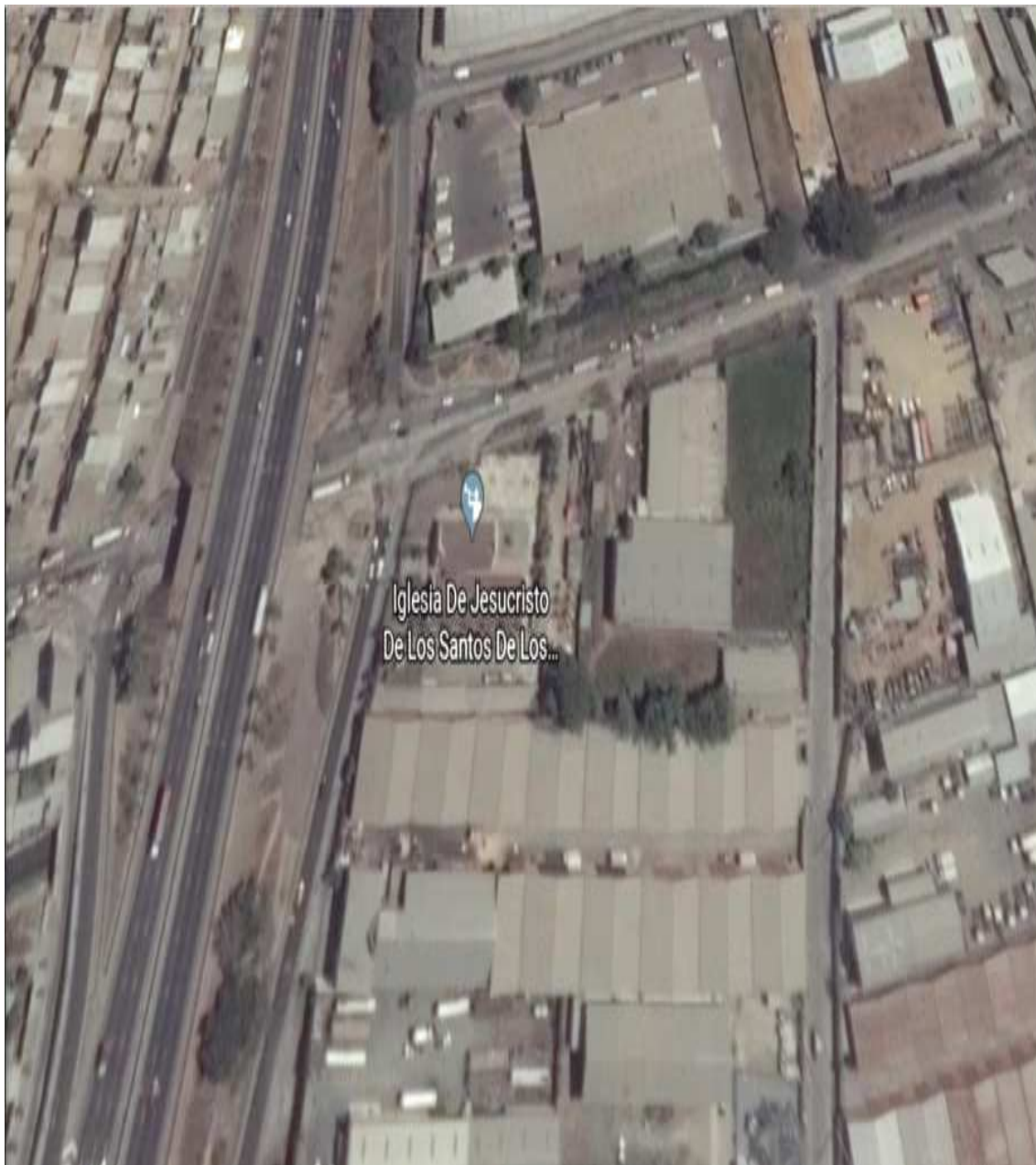
Figura 4.4: ubicación del sistema fotovoltaico Fuente: (Google Eart, 2018)
