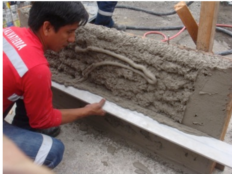
Ilustración 28: Aplicación de regla de aluminio al mortero
