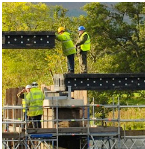
Ilustración 8: Puente de plástico Vertech Ltd
