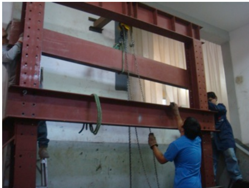
Ilustración 43: Adecuación del laboratorio para las pruebas de compresión
