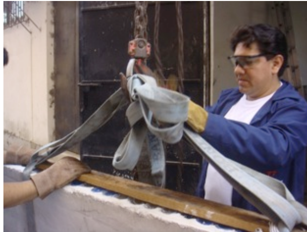
Ilustración 34: Colocación de banda para cargar el panel
