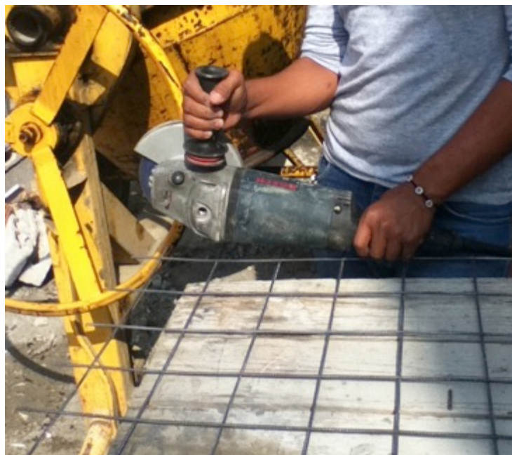
Ilustración 15: Corte de mallas
