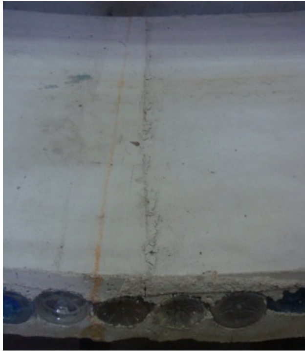
Ilustración 41: Falla en el punto de aplicación de la carga
