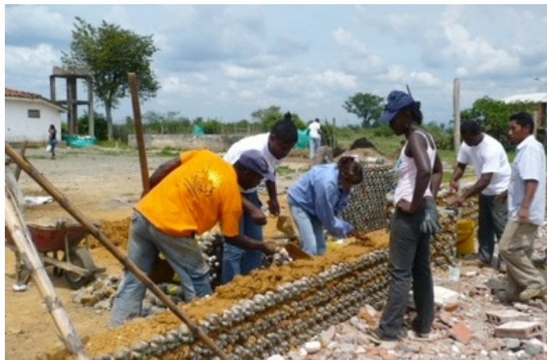
Ilustración 3: Construcción con eco-ladrillo
