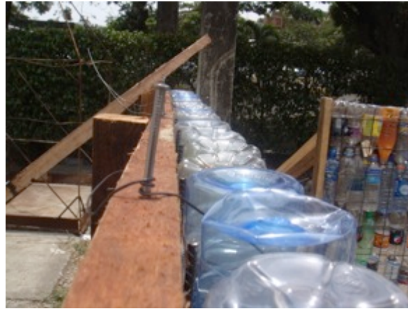
Ilustración 21: Alambre sujetando la malla al apuntalamiento
