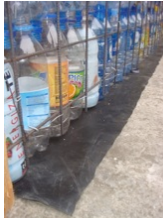
Ilustración 22: Tira de PVC colocada debajo del panel
