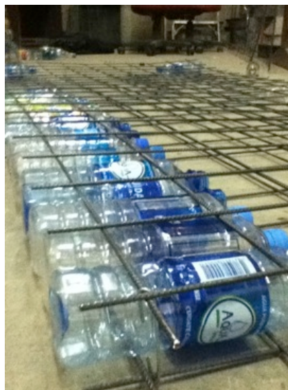
Ilustración 16: Armado de paneles
