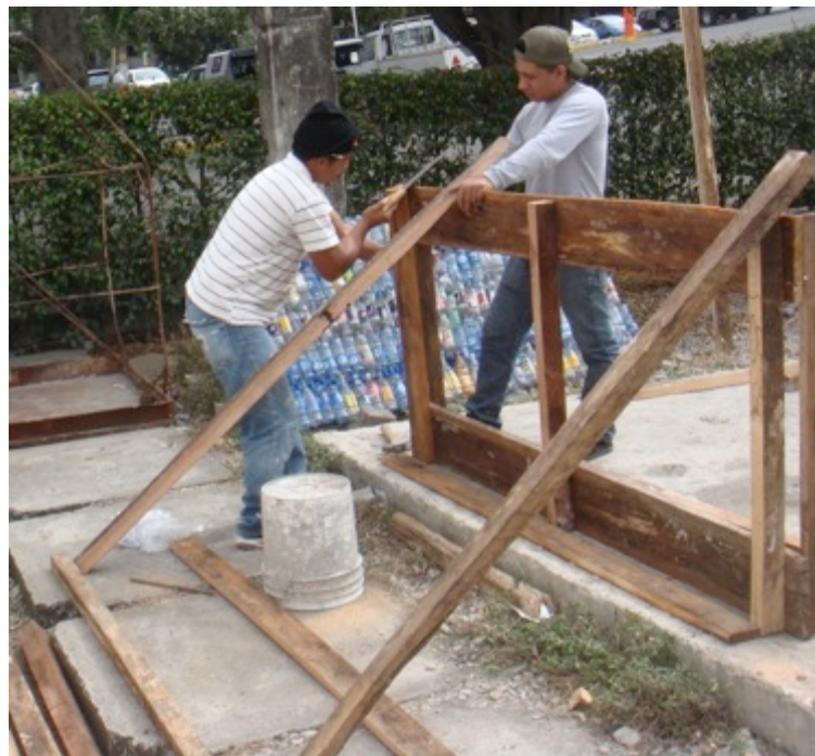
Ilustración 20: Encofrado para apuntalamiento
