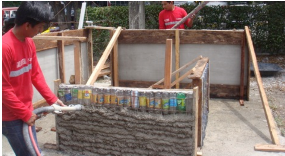
Ilustración 29: Paneles en la 2da proyección de mortero
