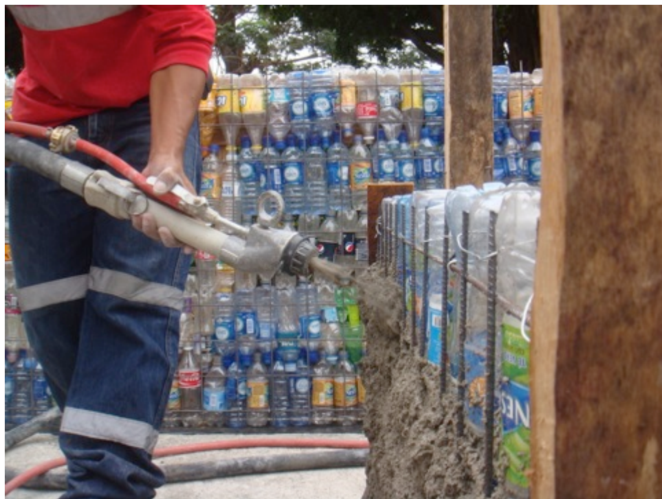
Ilustración 26: Proyección de mortero sobre el panel
