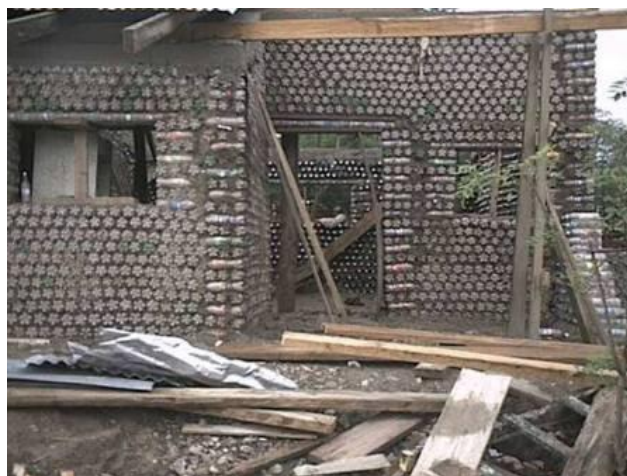
Ilustración 4: Casa a base de eco-ladrillos
