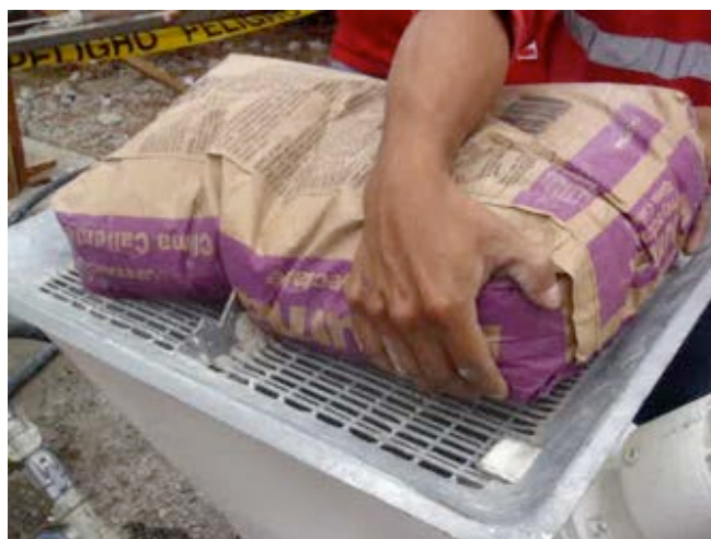
Ilustración 25: Colocando Enlumas en la dosificadora
