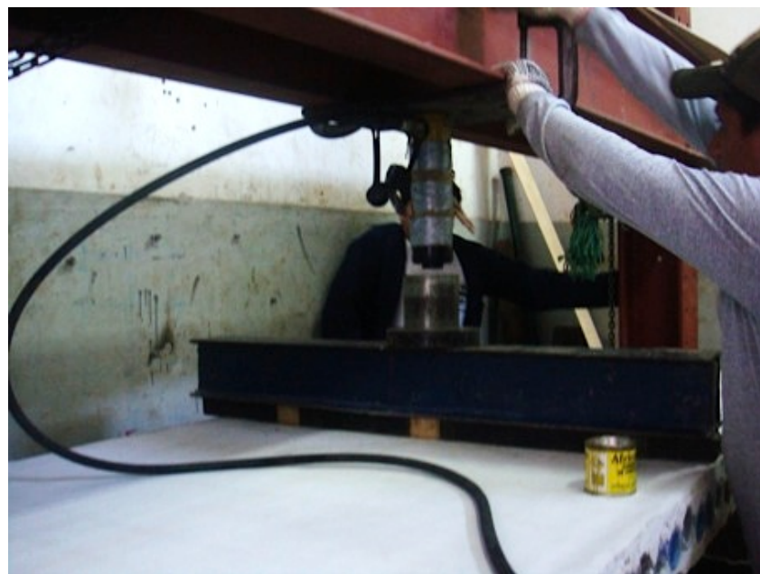
Ilustración 37: Colocación del gato hidráulico
