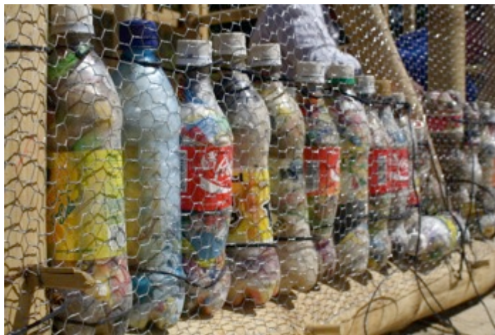
Ilustración 1: Letrina construida con botellas PET
