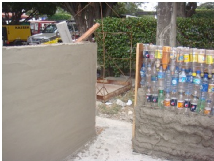
Ilustración 30: Vista de paneles con mortero y sin mortero
