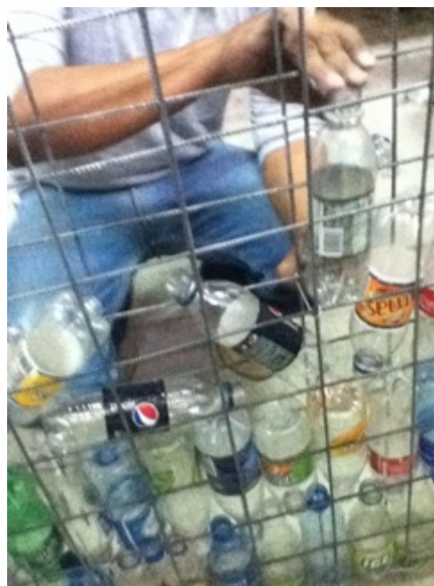
Ilustración 17: Colocación de botellas en el panel
