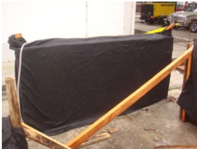
Ilustración 31: Geotextil colocado sobre el panel
