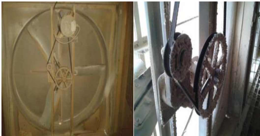
Figura 4. 4 Equipo extractor Marathon Electric y accionamiento por banda
