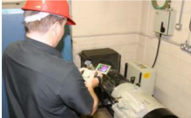
Figura 3. 4 Inspección de equipos eléctricos, utilizando la cámara termográfica
