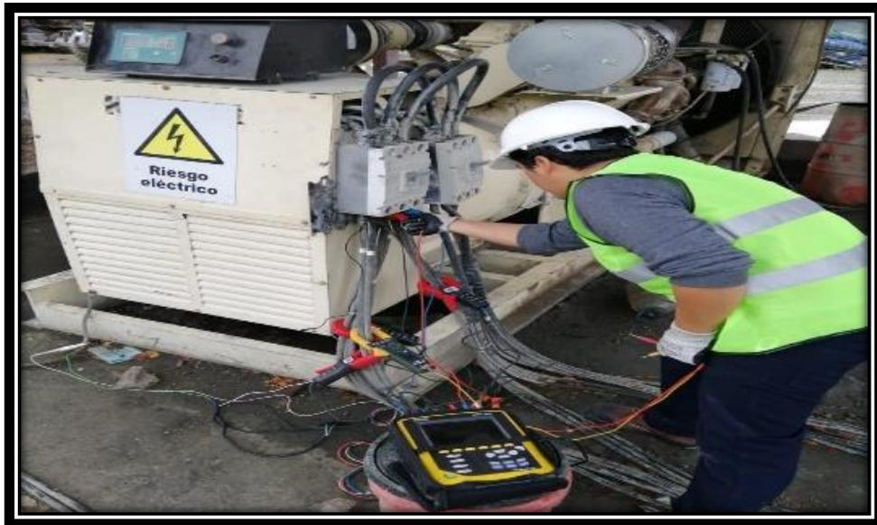
*Figura 2. 22. Instalación del analizador de redes eléctrico*
