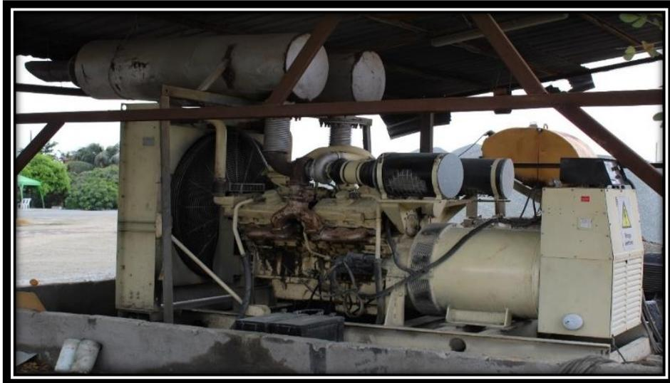
*Figura 2. 14. Motor generador eléctrico a diésel*
