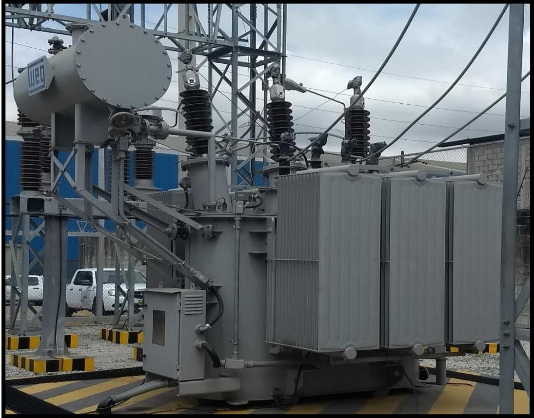
*Figura 2. 10. Transformador de potencia*
