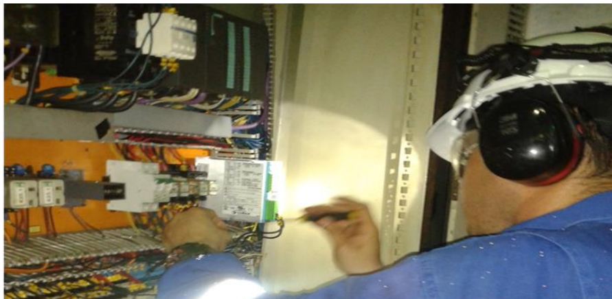
Figura 30: Montaje de Fuente 440Vac. Fuente: Autor.
