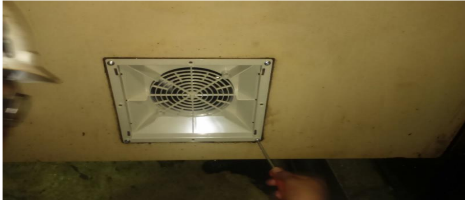
Figura 33: Montaje de ventilador. Fuente: Autor
