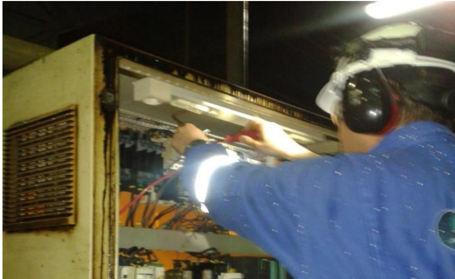
Figura 31: Desmontaje de caja de Fusibles. Fuente: Autor
