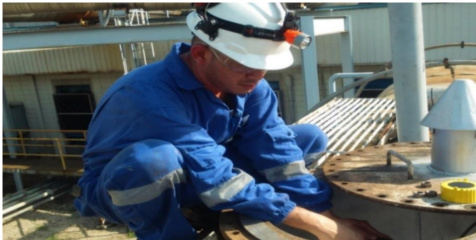
Figura 36: Realizando el montaje sensor radar. Fuente: Autor
