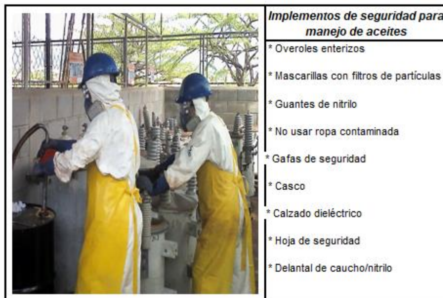
Figura 3.5. Equipo de protección personal - EPP Fuente: Ministerio de Ambiente (2015)
