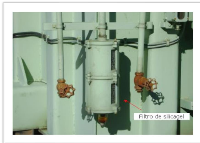
Figura 2.11. Filtro de silica gel Fuente: Bruno (2009)
