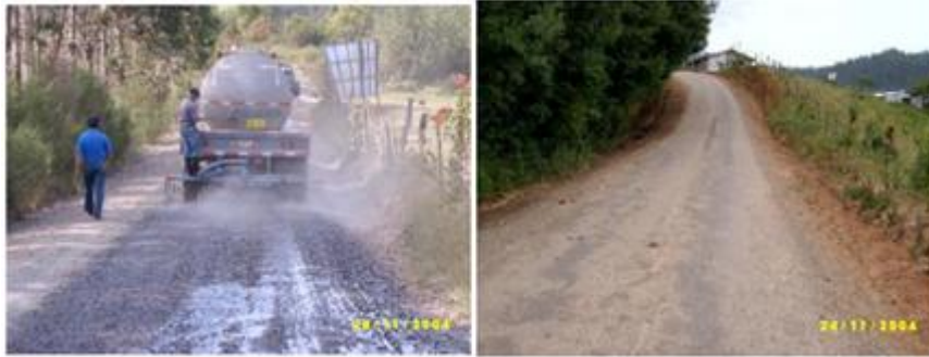
Ilustración 9 Caminos en la región del Bío Bío, estabilizado con Cloruro de Calcio, Chile Fuente: (Públicas., 2011)
