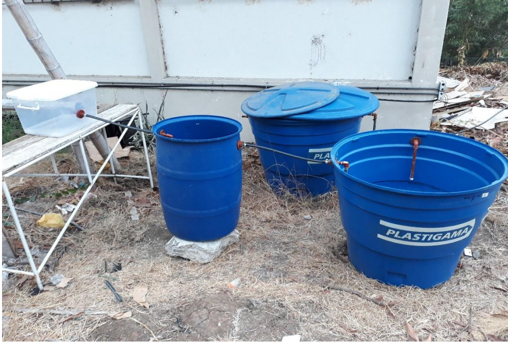
Ilustración 13 Planta piloto instalada
