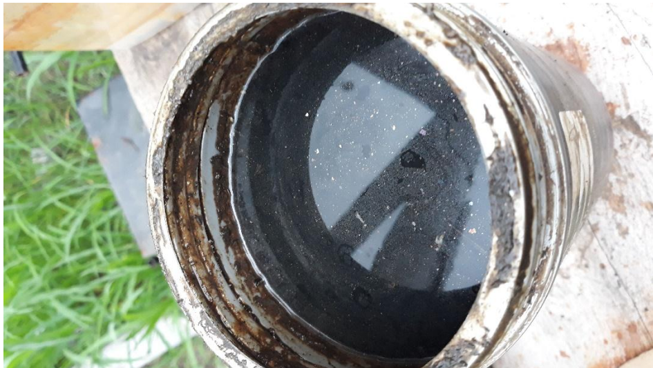
Ilustración 18 Lodo extraído puesto en el digestor
