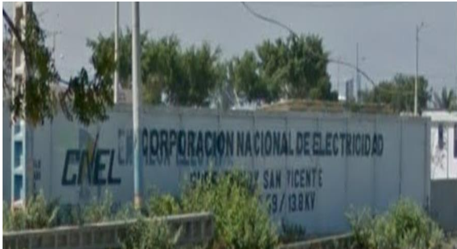
Figura 8. Subestación San Vicente 13.8 kV
