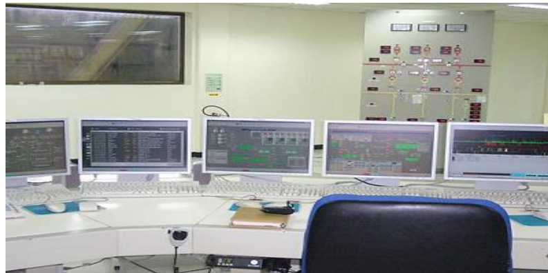
Figura 16. Sistema Scada
