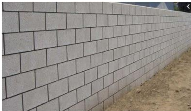
Ilustración 13. Construcción de mampostería con bloque de hormigón. Fuente: (“Types of Masonry Walls in Building Construction,” n.d.)
