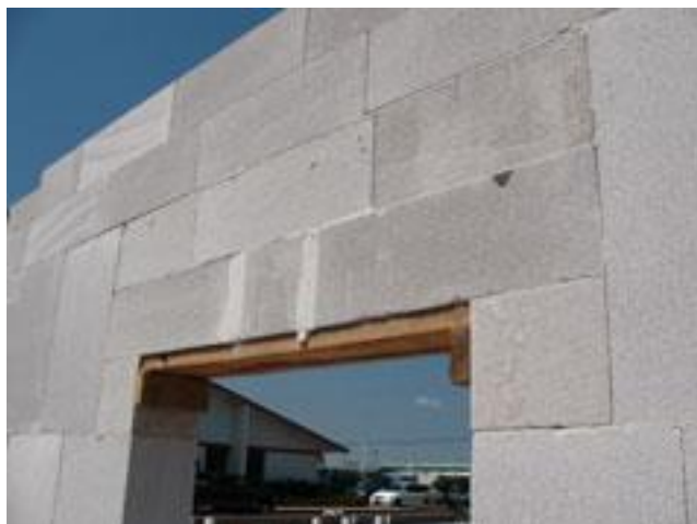
Ilustración 16. Los bloques o paneles curados de hormigón se unen con mortero de capa delgada. Fuente: (“Autoclaved Aerated Concrete,” n.d.)
