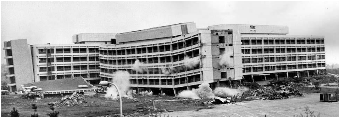
Ilustración 5. Hospital Olive View después del terremoto de 1971 en Sylma.
