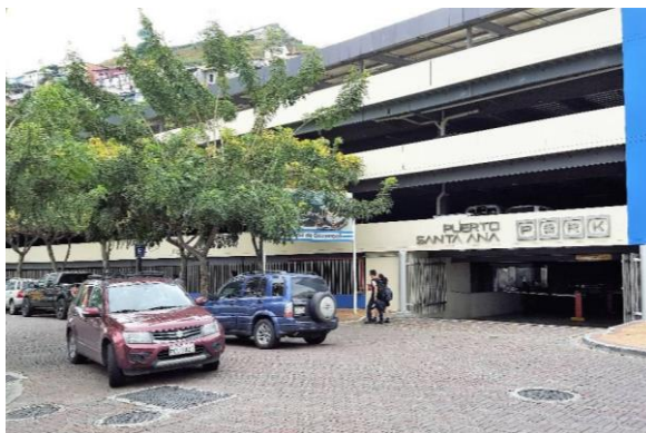
Figura 34. Edificio de parqueo del hotel. Fuente: Tomada de www.booking.com
