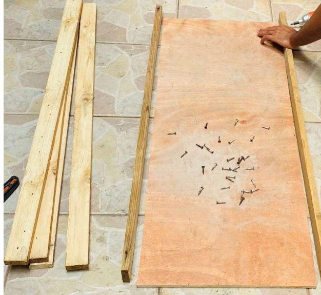
Figura 27. Construcción de encofrado para plancha ultraliviana - Parte 1. Fuente: Elaboración propia
