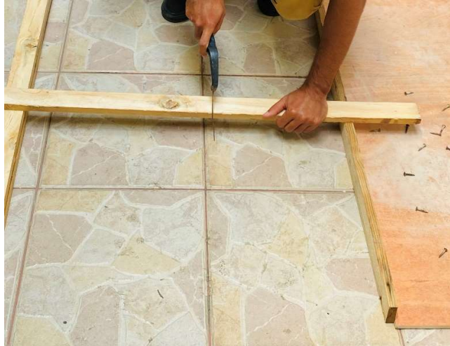
Figura 29. Construcción de encofrado para plancha ultraliviana - Parte 3. Fuente: Elaboración propia
