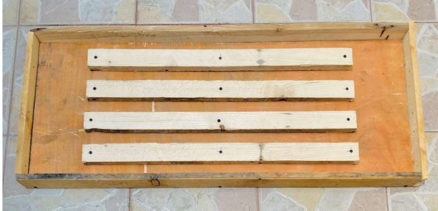
Figura 31. Encofrado para plancha de hormigón - Producto final. Fuente: Elaboración propia
