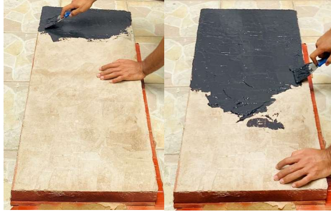
Figura 65. Aplicación de capa impermeabilizante. Fuente: Elaboración propia
