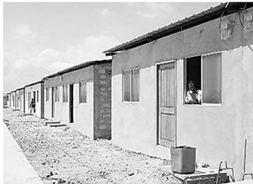
Figura 17. Vivienda social básica en Portoviejo, Ecuador. Fuente: Ministerio de Desarrollo Urbano y Vivienda, 2008
