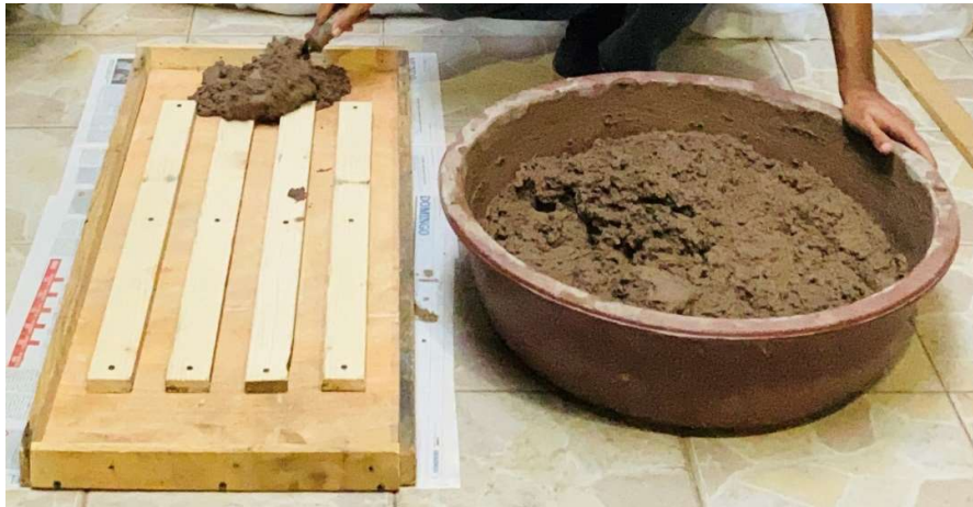
Figura 63. Fundición de plancha ultraliviana para cubierta. Fuente: Elaboración propia
