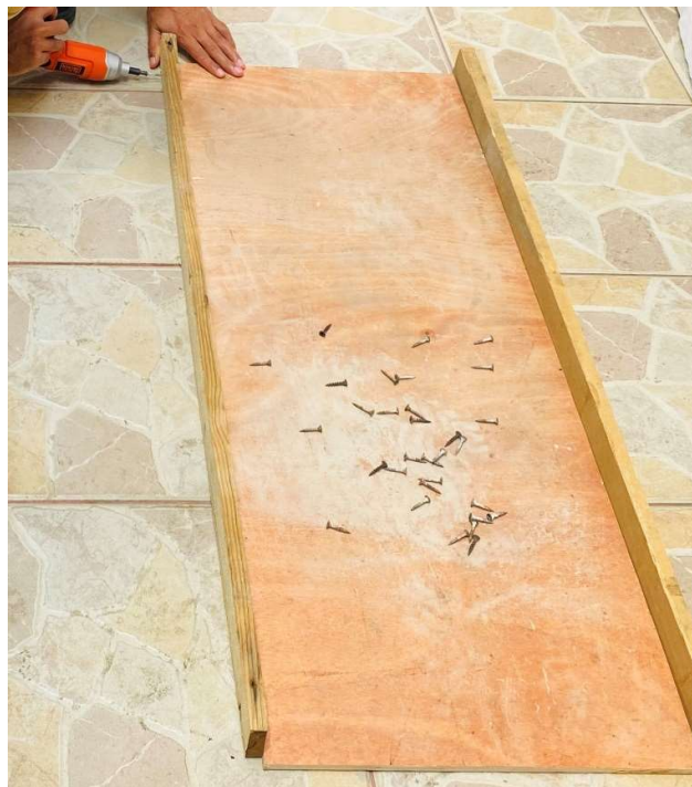
Figura 28. Construcción de encofrado para plancha ultraliviana - Parte 2. Fuente: Elaboración propia
