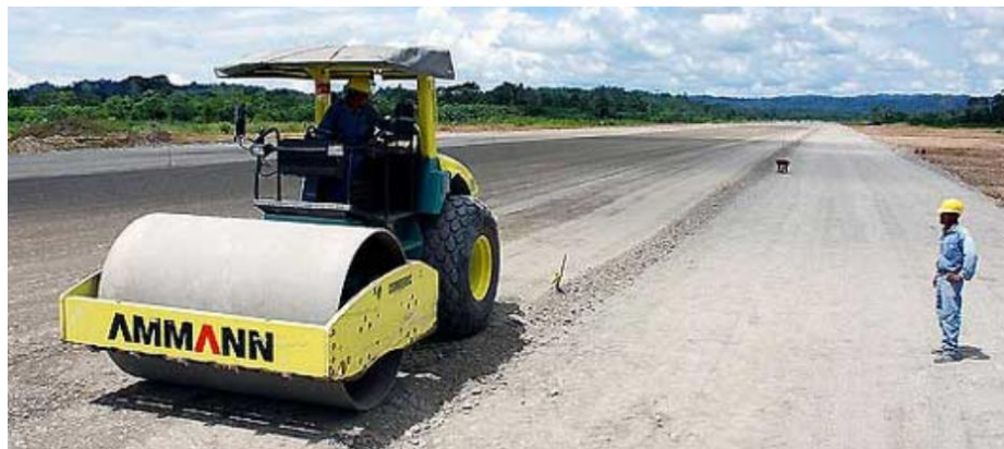
Ilustración 2 Compactación del Suelo.
