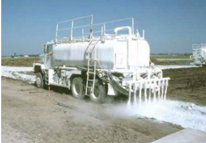
Ilustración 3 Aplicación de cal como método de estabilización del suelo.
