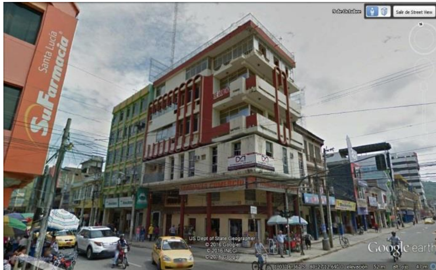
Figura 25. Edificio antes del terremoto del 16 de abril del 2016.
