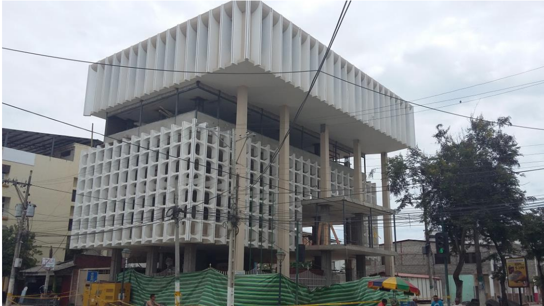
Figura 38. Estructura después del terremoto del 16 de abril del 2016. Obtenida por el Ing. Alex Villacrés.
