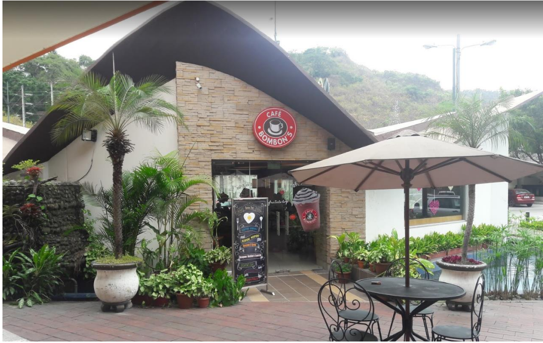
Figura 61. Cubierta con paraboloides hiperbólicas de hormigón armado.
