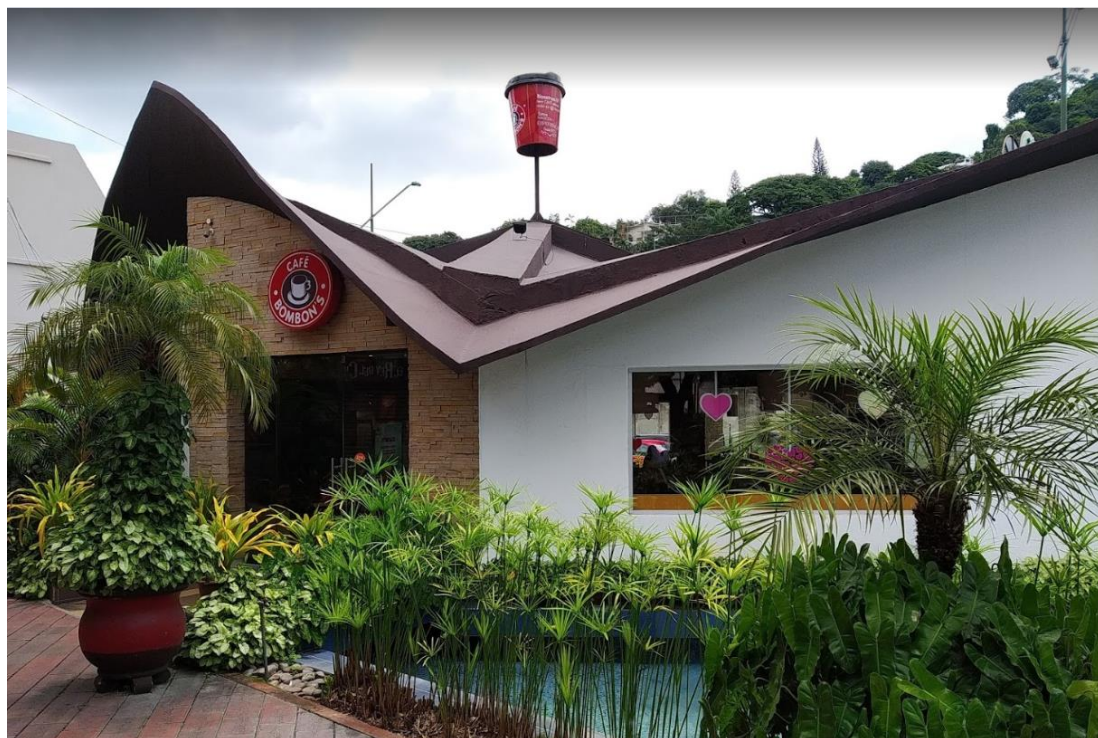
Figura 62. Cubierta con paraboloides hiperbólicas de hormigón armado.
