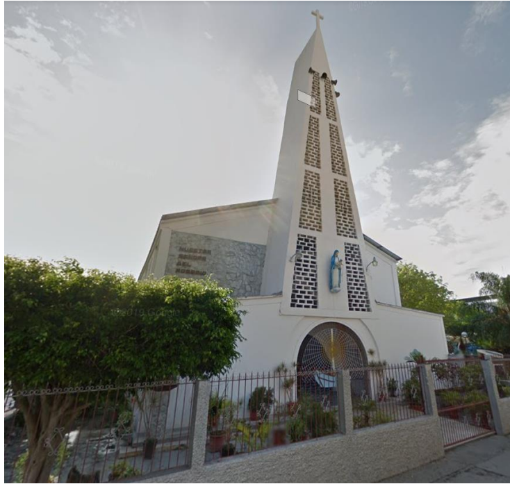
Figura 43. Estructura antes del terremoto del 16 de abril del 2016.
