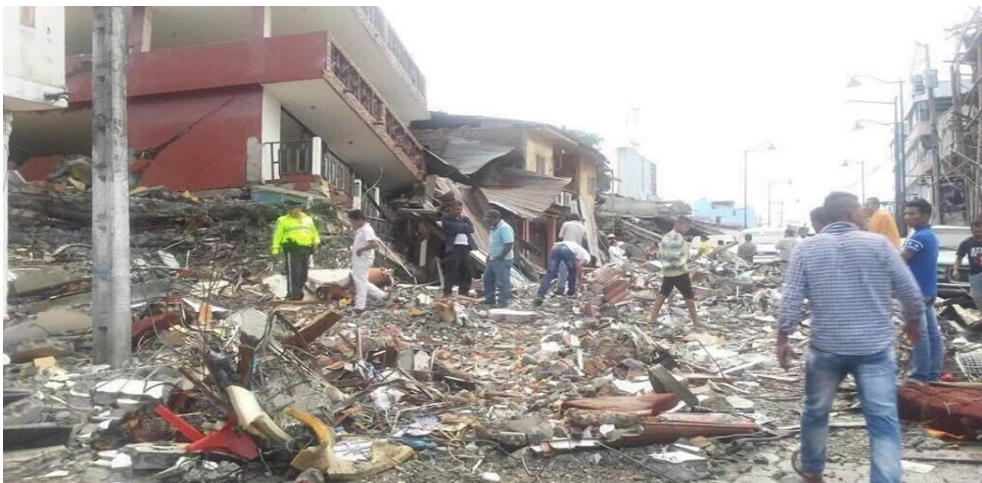
Figura 28. Edificio después del terremoto del 16 de abril del 2016.
