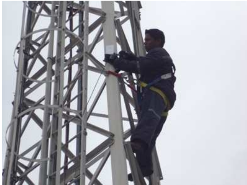
Figura # 4. 26 Instalación del segundo equipo
