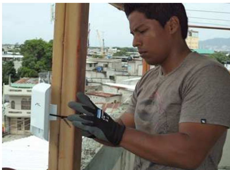
Figura # 4. 25 Instalación del primer equipo
