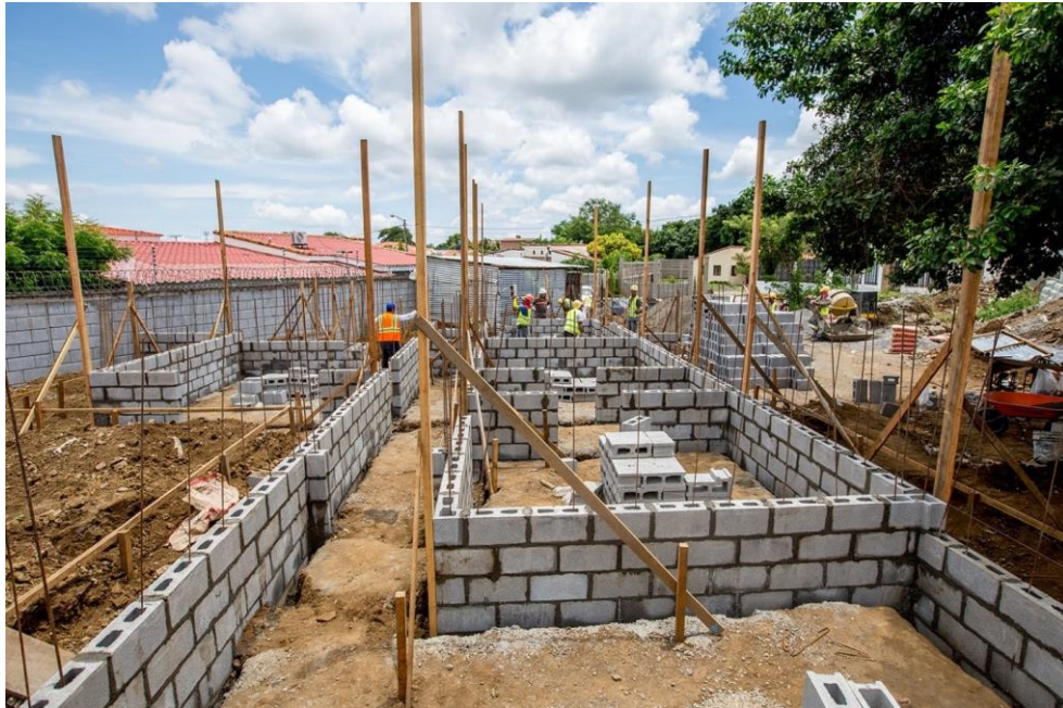
Ilustración 6. Construcción de estructura con mampostería reforzada. Por Yelce Cortez (2017).
