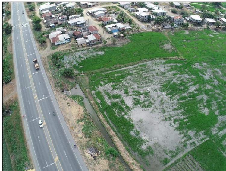
Ilustración 12. Carretera de acceso a la comunidad. Vía Santa Lucia-Daule
