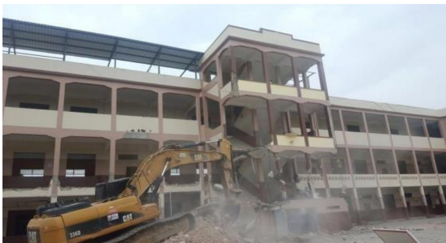
Ilustración 22 Demolición del centro educativo. Fuente: Ing. Alex Villacrés, 2017
