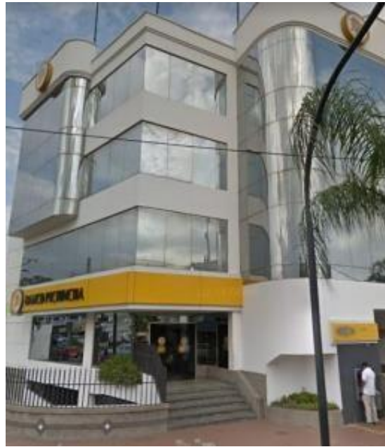
Ilustración 36 Edificio del Banco del Pichincha en Urdesa
