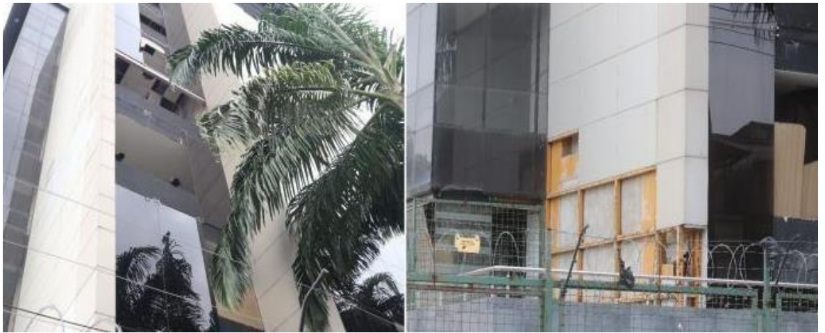
Ilustración 33 Antes y después del edificio Vihcar debido al sismo. Fuente: Diario Expreso, 2020
