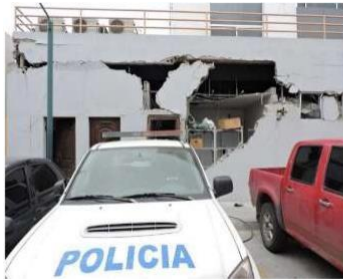
Ilustración 25 Daños en UVC de Manta. Fuente: Diario El Universo, 2016
