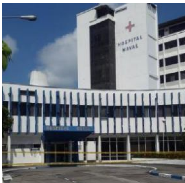
Ilustración 31 Instalaciones deshabilitadas luego del sismo. Fuente: Diario El Universo, 2016
