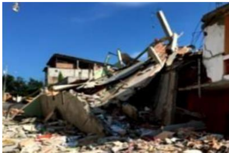
Ilustración 21 Parte colapsada de la U. E. Linus Palling. Fuente: GEER - ATC, 2016
