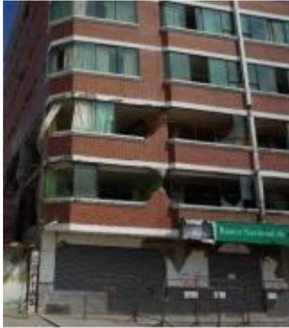
Ilustración 3 Edificio Venus Loor
