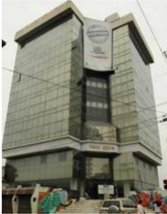
Ilustración 32 Instalaciones del edificio Vihcar
