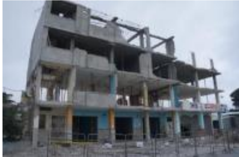
Ilustración 9 Edificio Juana Wacho
