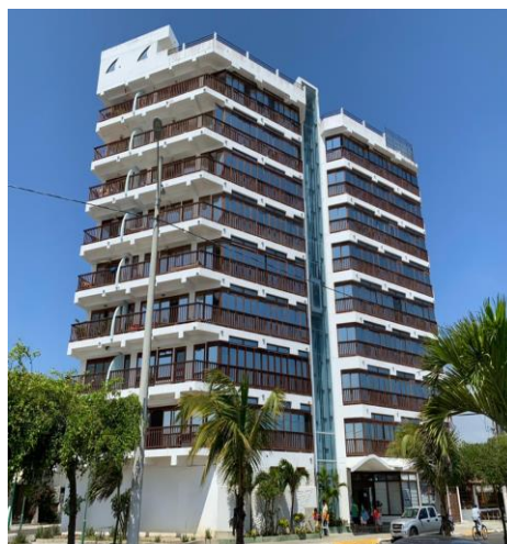
Ilustración 62: Vista lateral del Hotel Ocean Bay Towers después del terremoto del 2016.
