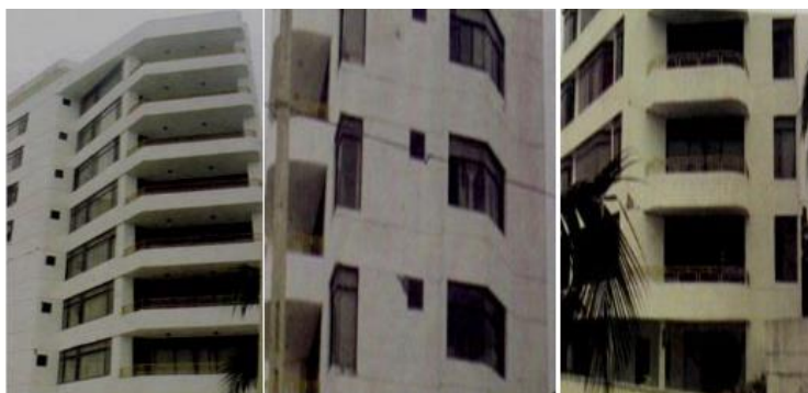
Ilustración 17: Edificio Torre Mar luego del terremoto de 1998
