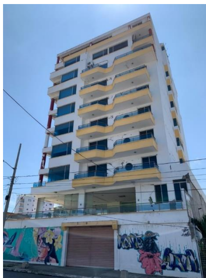
Ilustración 64: Vista lateral del Hotel Patricio's después del terremoto del 2016.
