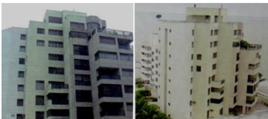
Ilustración 22: Edificio Vista Mar luego del terremoto de 1998
