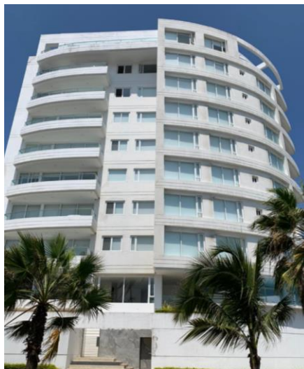
Ilustración 61: Vista frontal del Edificio El Faro, reparado después del terremoto del 16 de abril del 2016.
