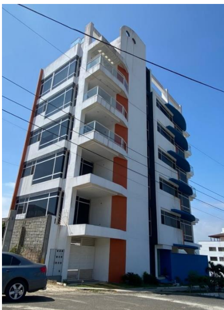
Ilustración 67: Vista lateral del edificio Bahía de Caráquez actualmente.
