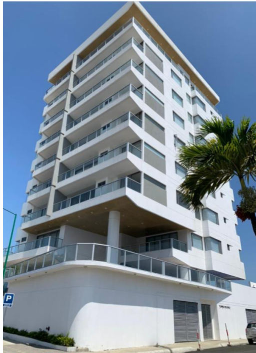
Ilustración 50: Vista lateral del Edificio Torre Molino, reparado después del terremoto del 16 de abril del 2016.
