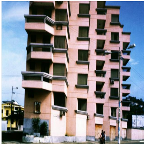
Ilustración 23: Edificio El Pirata luego del sismo de 1998
