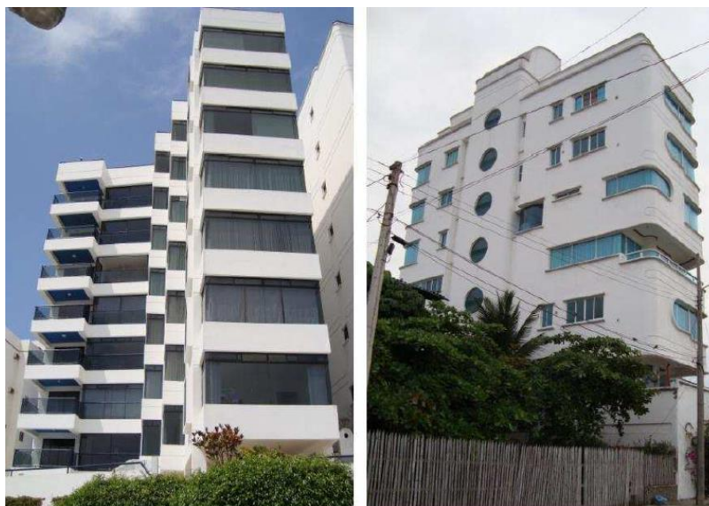
Ilustración 8: Irregularidades arquitectónicas. A la derecha el Edificio El Almirante (irregularidad en planta), a la izquierda Edificio sin nombre (Irregularidad en elevación)
