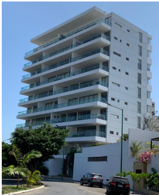
Ilustración 54: Vista lateral del Edificio Cariló, reparado del terremoto del 16 de abril del 2016.
