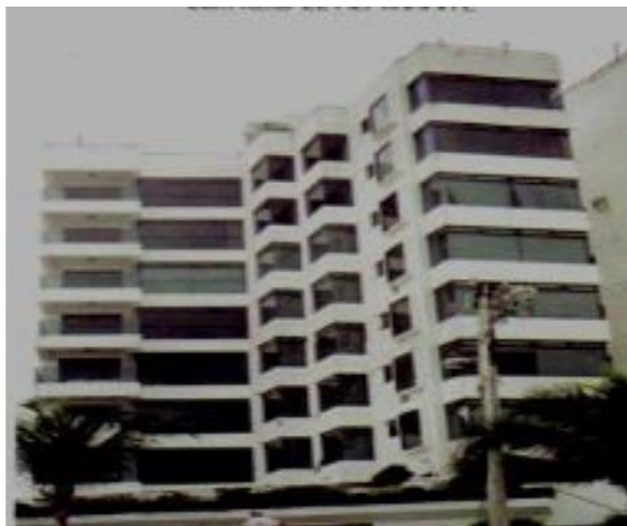
Ilustración 19: Edificio El Almirante luego del terremoto de 1998
