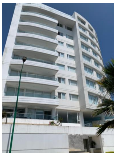
Ilustración 59: Vista frontal del Edificio El Faro, reparado después del terremoto del 16 de abril del 2016.
