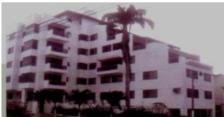
Ilustración 35: Edificio Av. Riofrío y Salinas luego del terremoto de 1998
