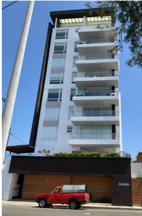
Ilustración 48: Vista frontal del Edificio Akuaba, reparado después del terremoto del 16 de abril del 2016.
