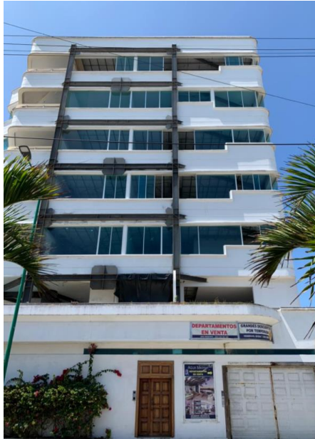
Ilustración 45: Vista frontal del Edificio Agua Marina, está siendo reforzado después del terremoto del 16 de abril del 2016.
