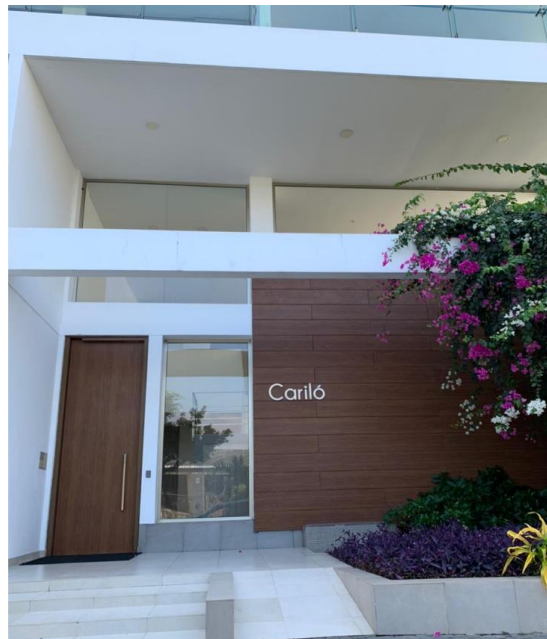
Ilustración 56: Entrada principal después de la reparación del Edificio Cariló.
