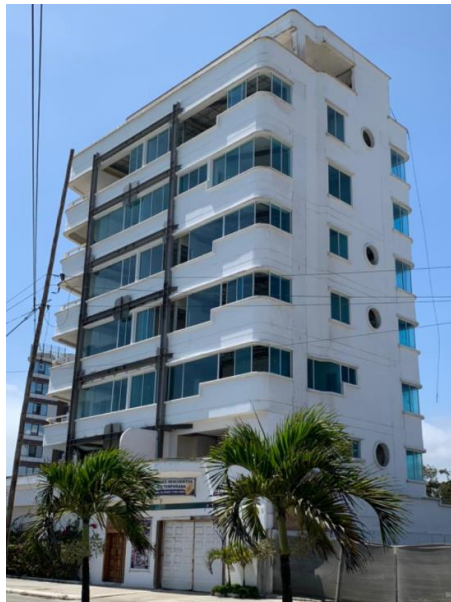
Ilustración 44: Vista lateral del Edificio Agua Marina, está siendo reforzado después del terremoto del 16 de abril del 2016.
