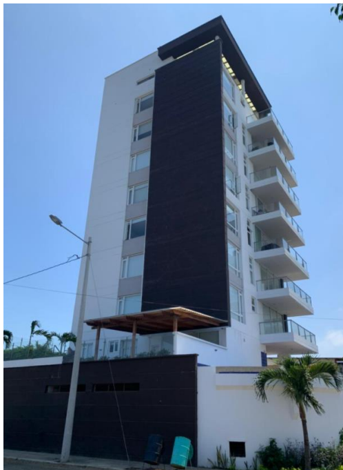
Ilustración 49: Vista lateral del Edificio Akuaba, reparado después del terremoto del 16 de abril del 2016.
