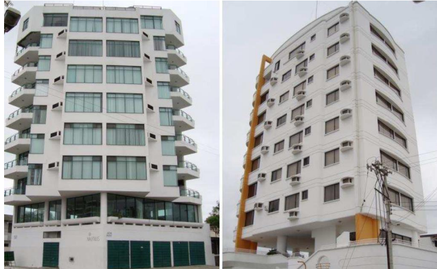
Ilustración 9: Pisos blandos en construcciones. A la derecha el Edificio Salango, a la izquierda el Nautilus
