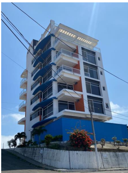
Ilustración 66: Vista lateral del Edificio Bahía actualmente.
