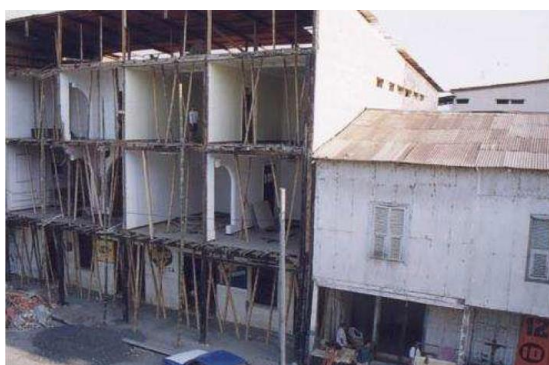
Ilustración 11: Incompatibilidad de materiales en edificación de Bahía
