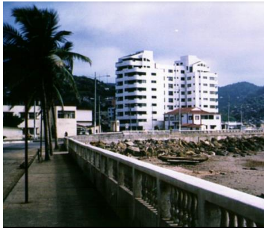
Ilustración 12: Edificio Dos hemisferios luego del sismo de 1998
