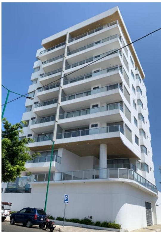
Ilustración 51: Vista lateral del Edificio Torre Molino, reparado después del terremoto del 16 de abril del 2016.
