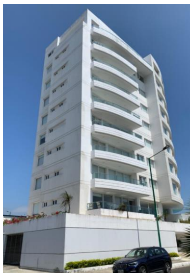
Ilustración 58: Vista lateral del Edificio El Faro, reparado después del terremoto del 16 de abril del 2016.
