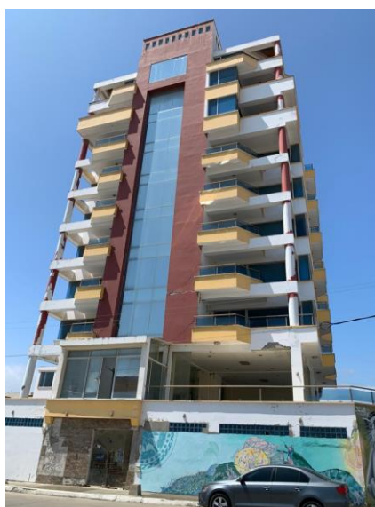
Ilustración 63: Vista frontal del Hotel Patricio's después del terremoto del 2016.
