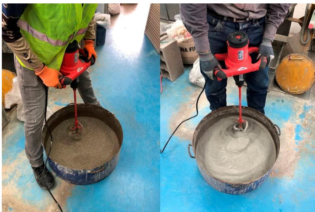
Ilustración 3 Mezcla de arena y cemento
