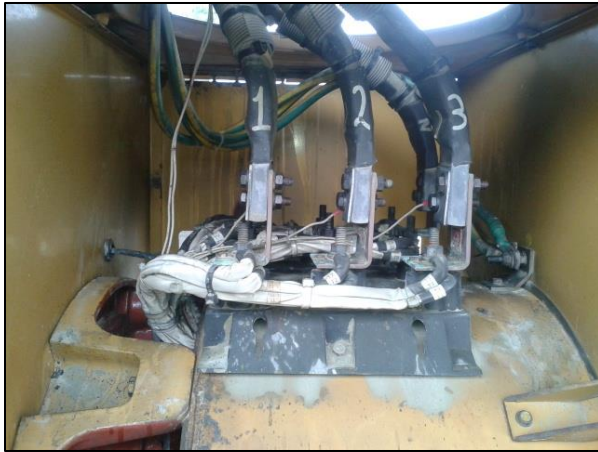
Figura 3.5: Desmontaje de guardas para acceder a las bobinas del generador Elaborado por: Autor
