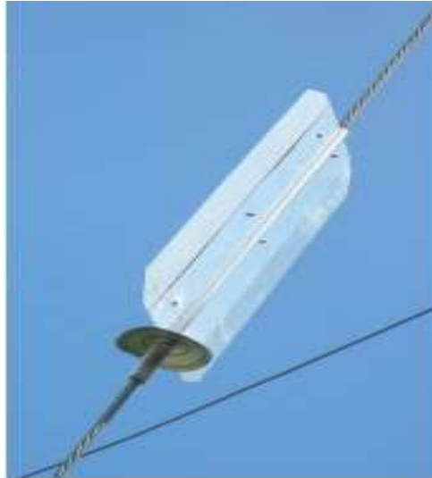
Figura 2-31: Dispositivo antiescalamiento Fuente: (CNFL, 2020)
