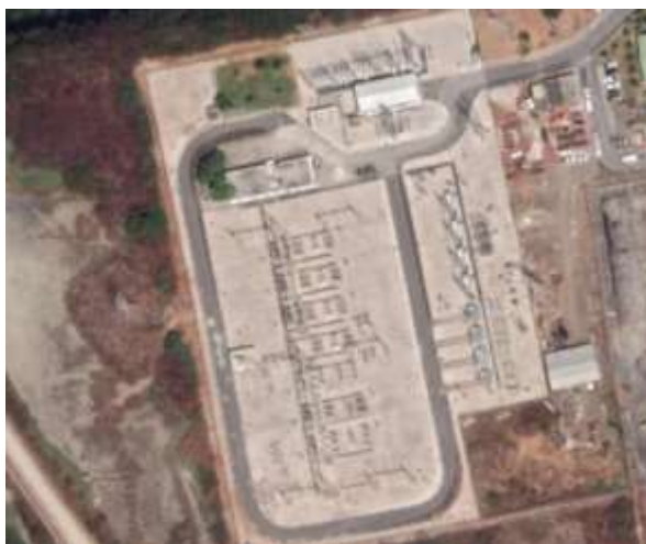
Figura 2-29: Subestación eléctrica Salitral Fuente: (CELEC, 2018)
