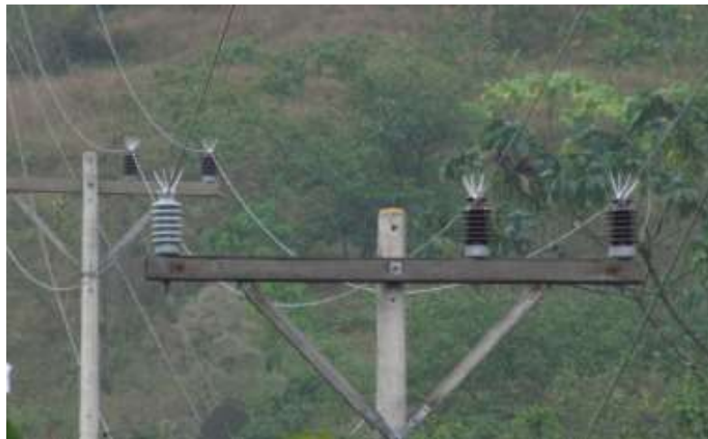
Figura 2-34: Dispositivo anti-percha tipo pico de paloma
