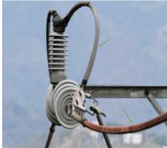
Figura 2-37: Protectores de hule de silicón tipo manguera, para aislar el Jumper y polímero rígido para el cable
