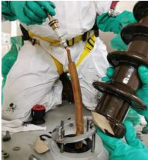
Figura 2-23: Reemplazo de bushing dañado en un transformador eléctrico Fuente: Cite Energía, 2019
