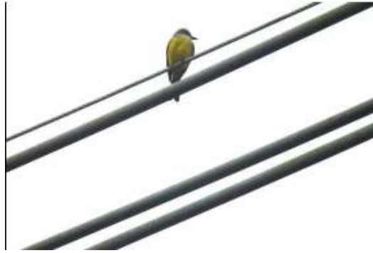
Figura 2-38: Cable conductor con recubierta semiaislada Fuente: (ESHP, 2020)
