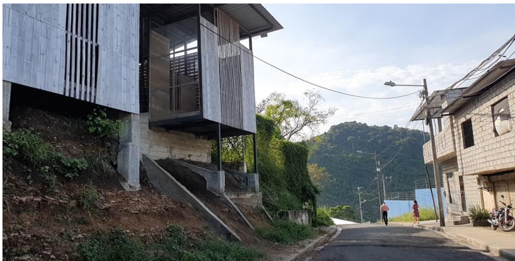
Figura 3. 2 Acceso dos (sur) al inmueble Consultorio Urbano UCSG
