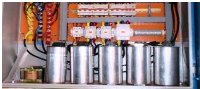
Figura 2.9. Almacenamiento de corriente capacitiva Fuente:(Puerta, 2018)
