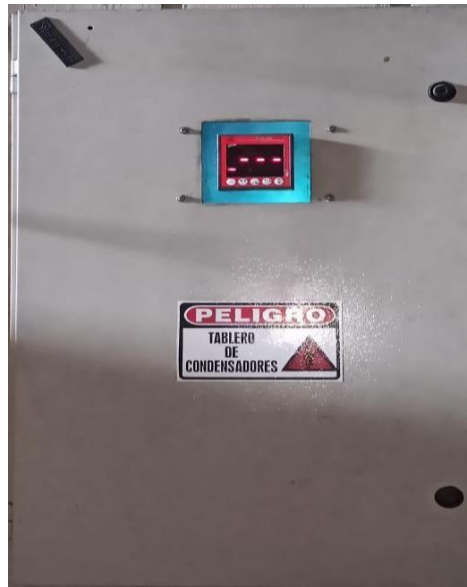
Figura 3.21. Instalación de controlador Ducatti R5. Fuente: (ENSA,2022)
