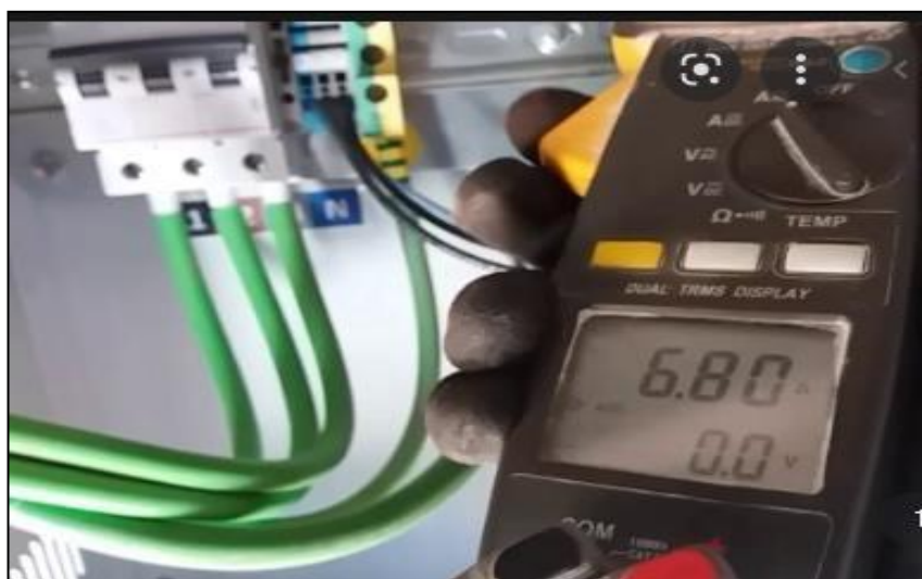
Figura 2.25. Medición amperaje Banco Capacitares. Fuente:(Fluke, 2021)
