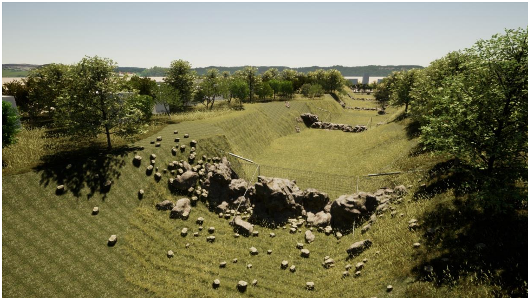
Figura 98 Vista esquemática de las defensas dinámicas sucesivas para flujo de detritos
