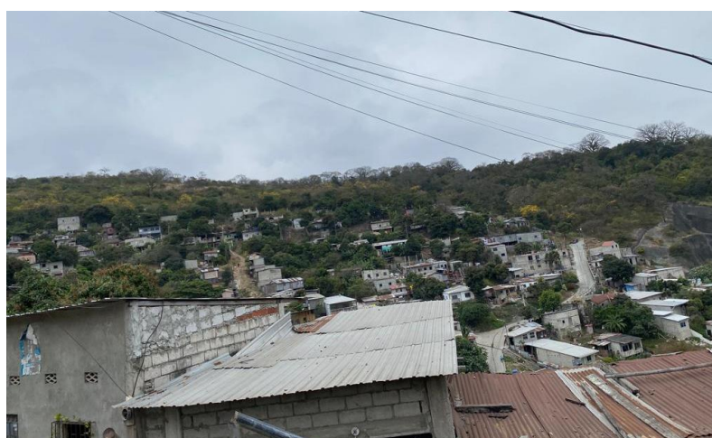
Figura 6. Expansión urbana no planificada en el cerro San Eduardo (zona 2), junto a la entrada del túnel San Eduardo
