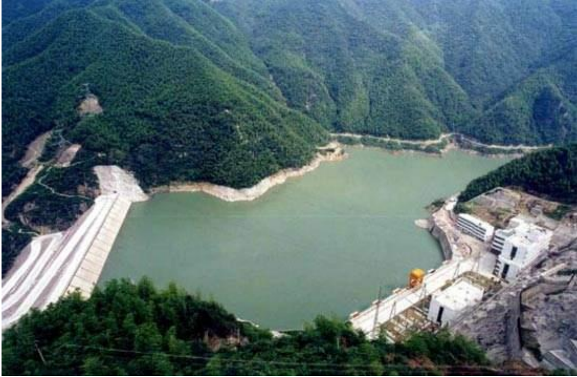
Ilustración 83. Embalse inferior de la central hidroeléctrica reversible de Tianhuangping.
