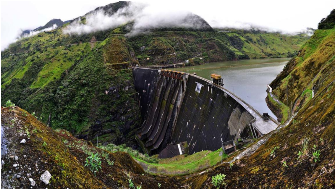
Ilustración 48. Central Hidroeléctrica Paute-Molino: Presa Daniel Palacios. Fuente: Primicias
