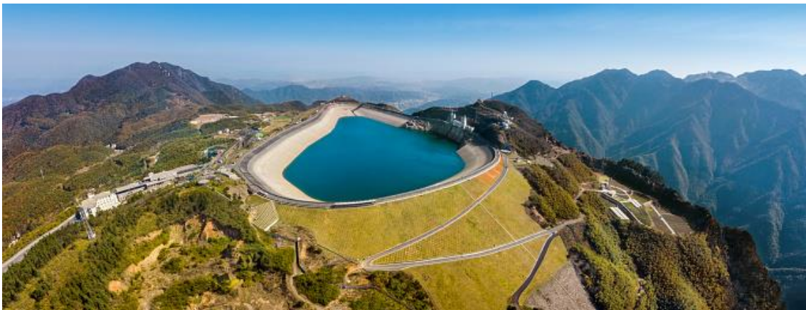
Ilustración 82. Embalse superior de la central hidroeléctrica reversible de Tianhuangping.
