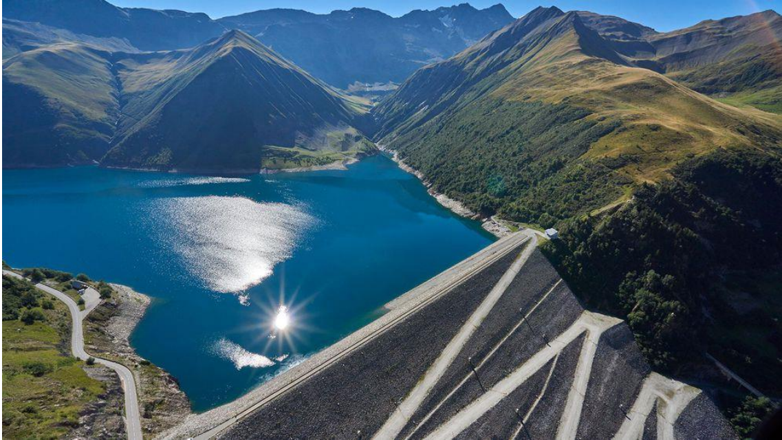
Ilustración 80. Embalse superior de central hidroeléctrica reversible Grand'Maison. Fuente: NS Energy
