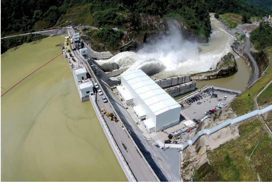
Ilustración 35. Central hidroeléctrica Manduriacu. Quito-Cotacachi, Ecuador. Fuente: Corporación Eléctrica del Ecuador (CELEC)
