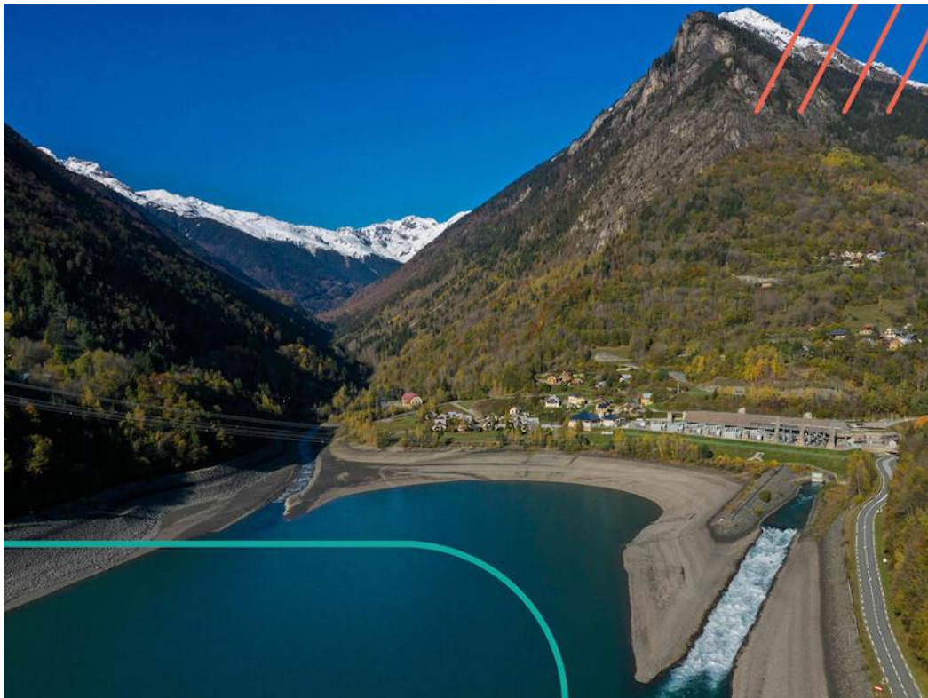
Ilustración 81. Embalse inferior de central hidroeléctrica reversible Grand'Maison. Fuente: NS Energy
