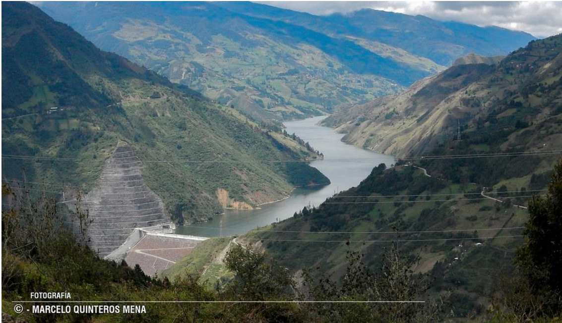
Ilustración 43. Central Hidroeléctrica Paute-Mazar. Fuente: Quintero (2016)
