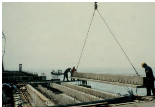
Ilustración 49 Montaje de viga prefabricada. Fuente: autor
