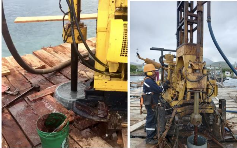
Ilustración 47 Barrenado del pilote; Fuente: autor
