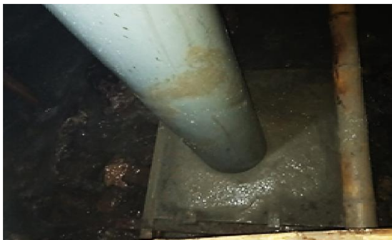
Ilustración 45 Colocación del muerto estructural; Fuente: autor
