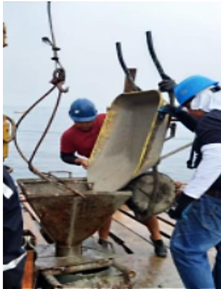
Ilustración 48 Fundición del pilote; Fuente: autor
