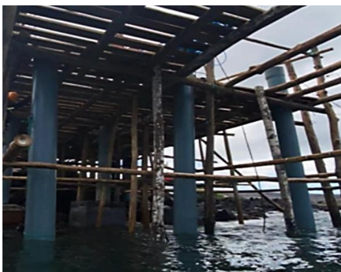
Ilustración 46 Posicionamiento de tubo PVC ; Fuente: autor
