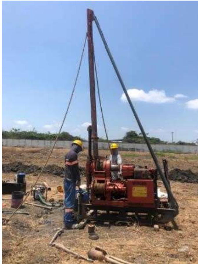
Ilustración 32. Equipo utilizado para el ensayo SPT. (Autoría propia)
