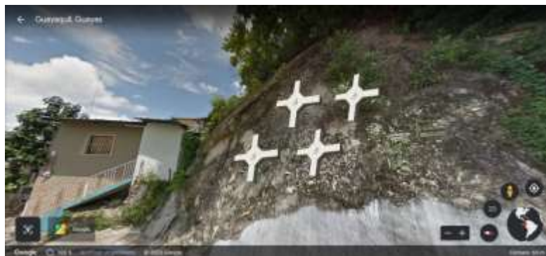
Figura 84. Cuatro crucetas instaladas al pie del talud en zona expuesta (zona cerro San Eduardo-Monumental)
