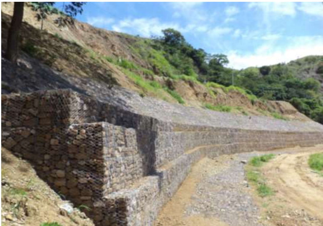
Figura 23. Muro de gaviones intradós escalonado con inclinación paralelo al talud
