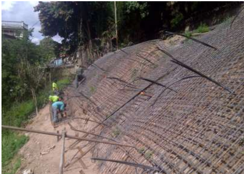
Figura 41. Fundición de pantalla de hormigón armado proyectado.
