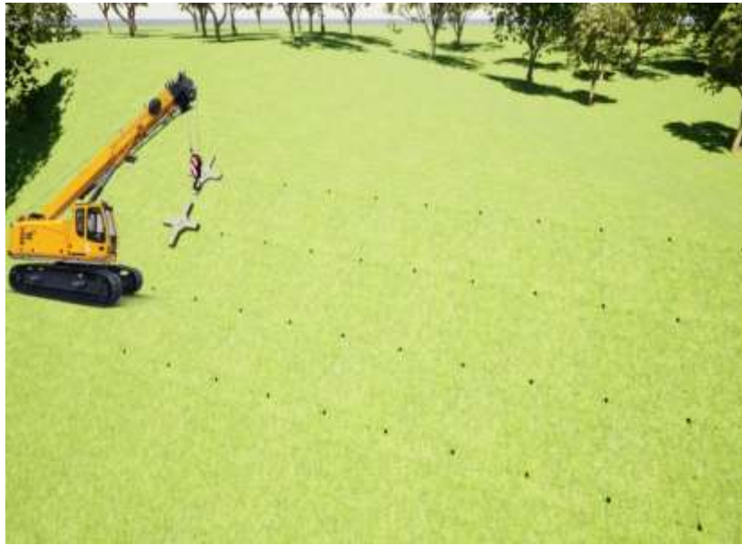
Figura 58. Colocación de crucetas prefabricadas mediante grúa
