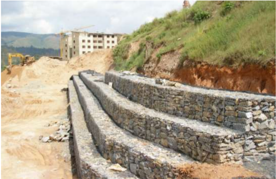
Figura 22. Muro de gaviones en intradós escalonado y trasdós vertical.
