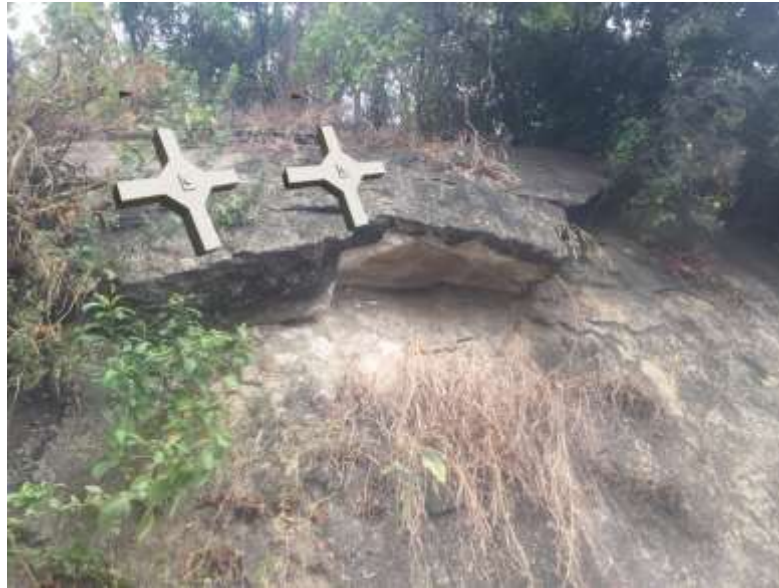
Figura 87. Una cruceta instalada al pie del talud en zona expuesta (zona cerro San Eduardo-Monumental)
