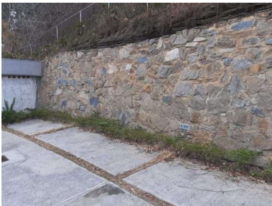
Figura 25. Muro de hormigón ciclópeo al pie de talud.
