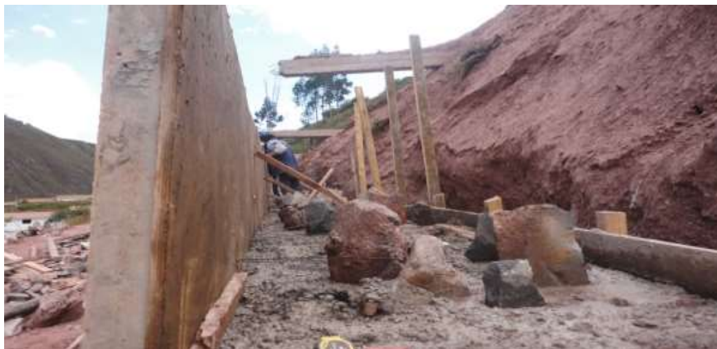
Figura 24. Fundición de primera capa del muro de hormigón ciclópeo
