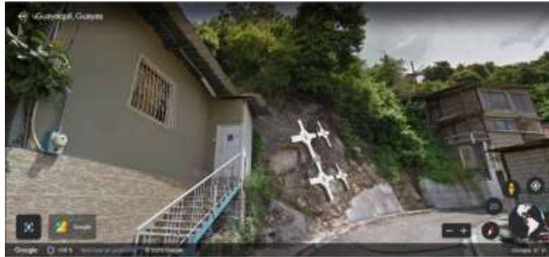
Figura 85. Cuatro crucetas instaladas al pie del talud en zona expuesta (zona cerro San Eduardo-Monumental)
