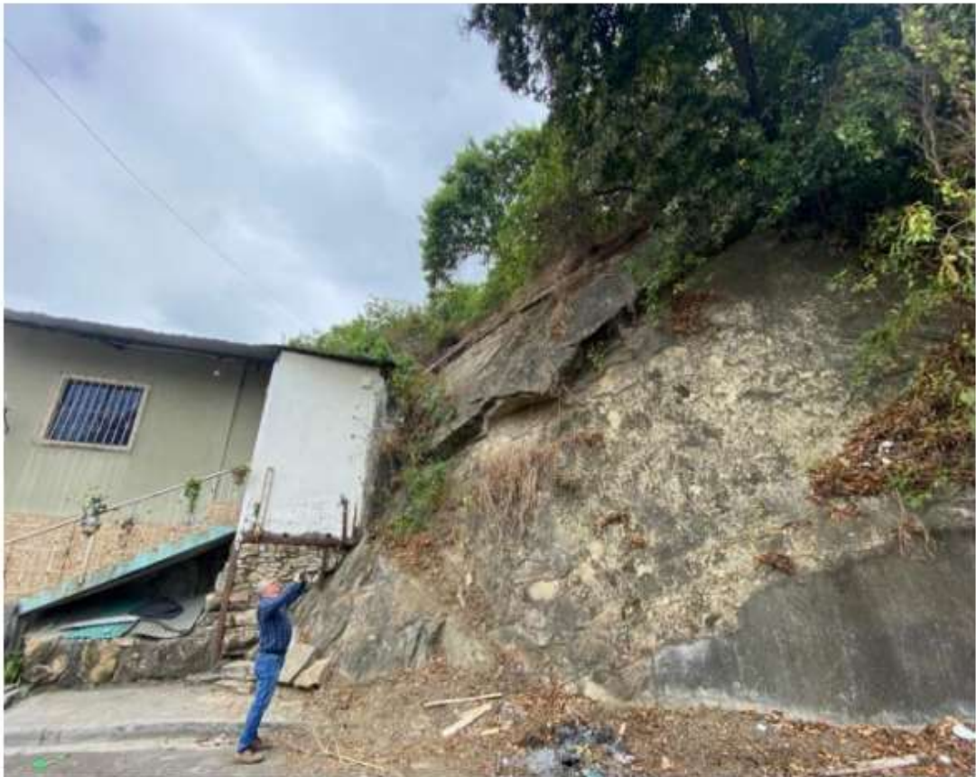
Figura 19. Afloramiento de estratos del macizo rocoso zona cerro San Eduardo-Monumental
