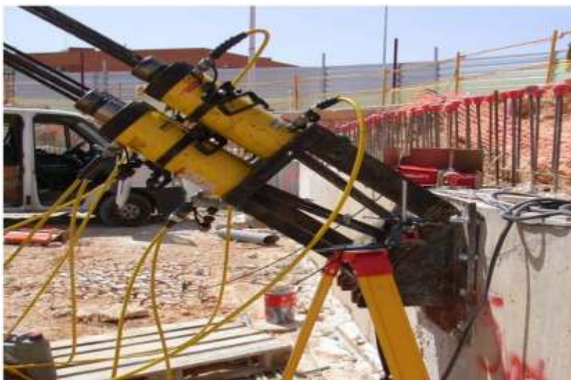
Figura 36. Doble tensado simultaneo de anclajes mediante gato hidráulico
