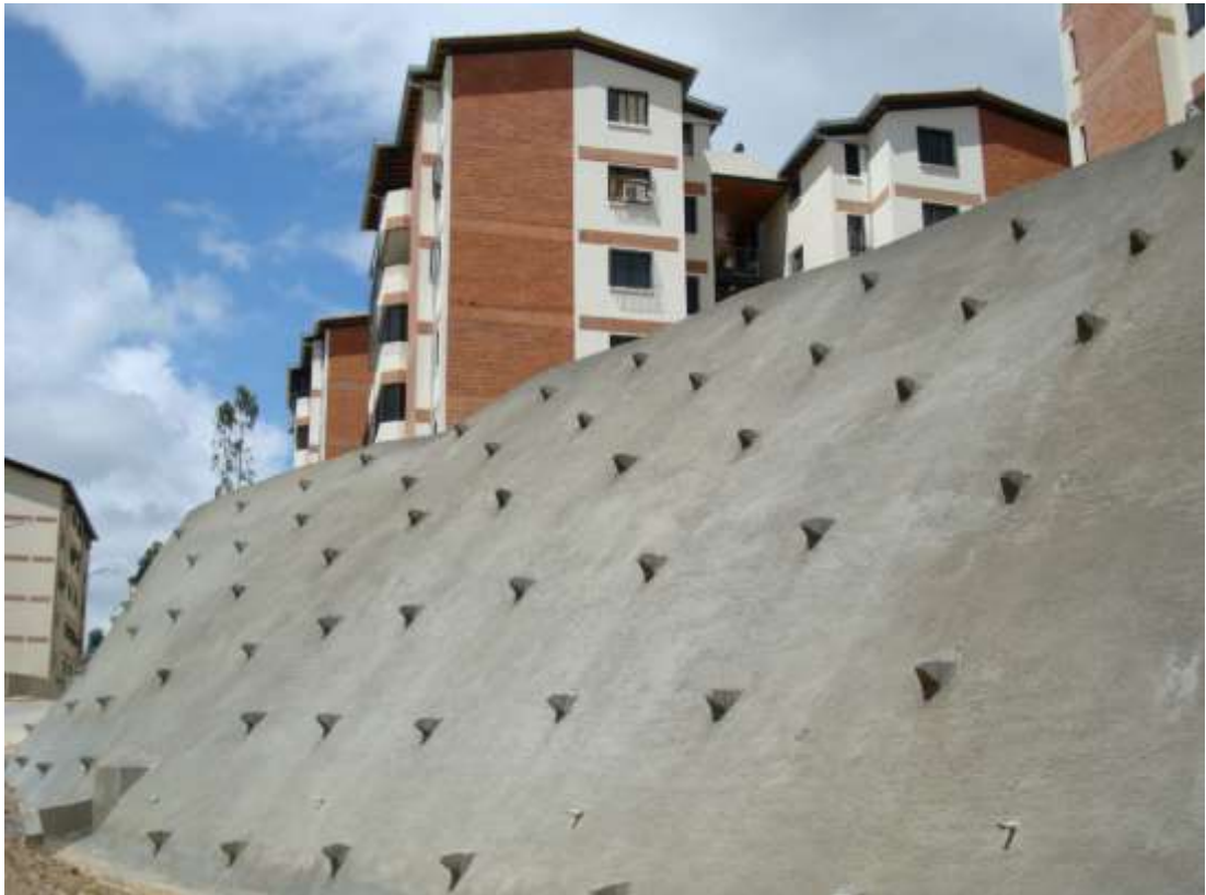
Figura 42. Pantalla de hormigón armado proyectado
