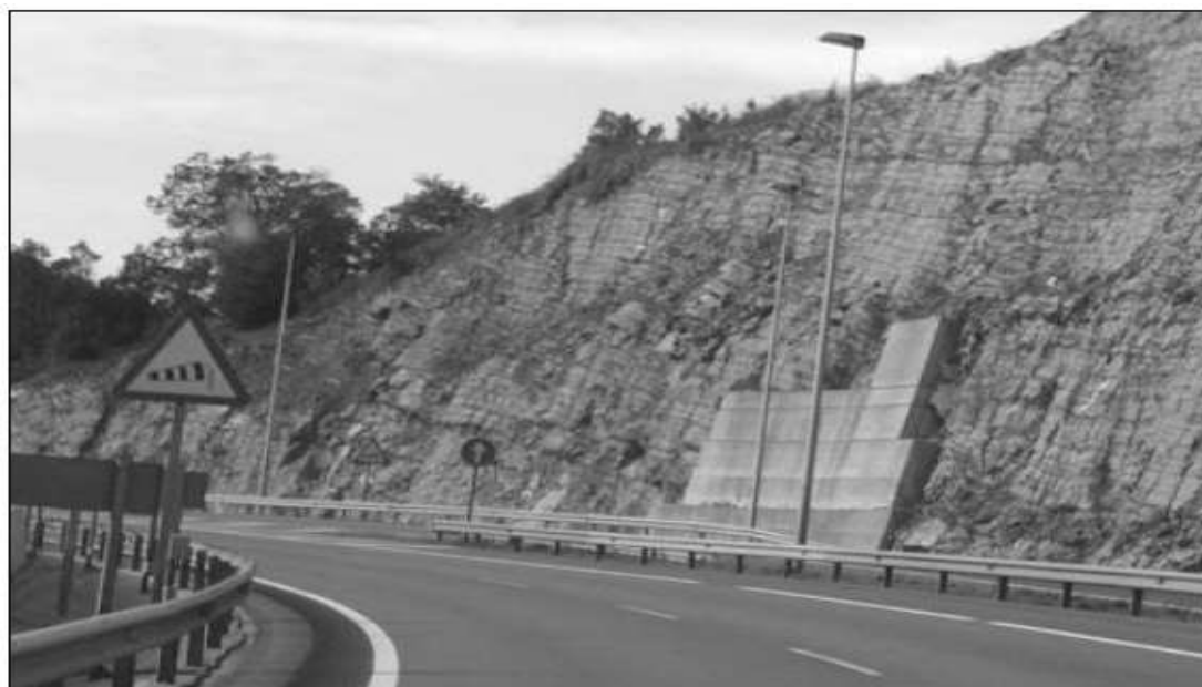
Figura 28. Muros de hormigón armado en macizo rocoso.
