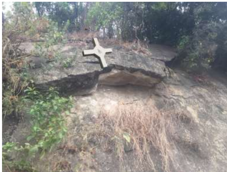
Figura 86. Una cruceta instalada al pie del talud en zona expuesta (zona cerro San Eduardo-Monumental)
