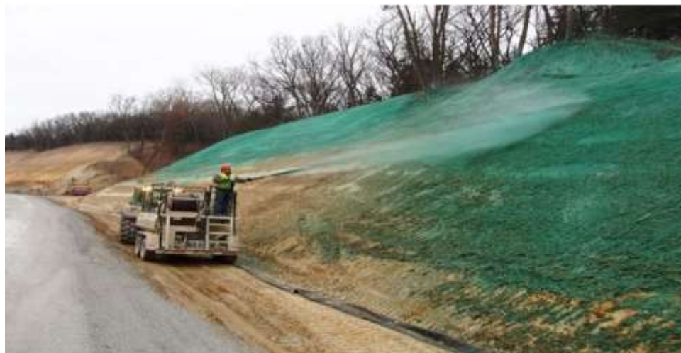
Figura 88. Hidro sembrado proyectado a presión
