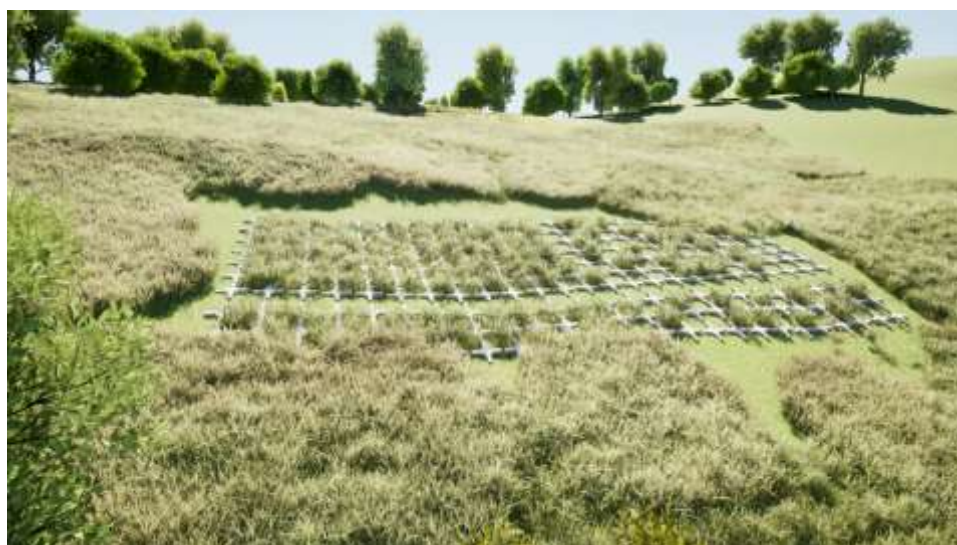
Figura 89. Protección superficial del talud mediante cobertura vegetal
