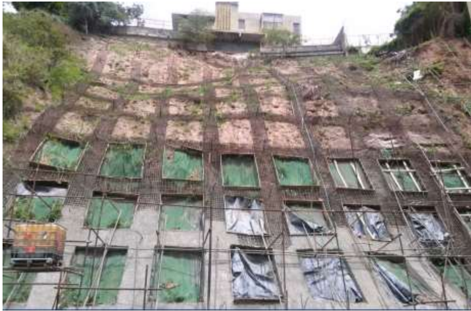
Figura 43. Fundición en sitio de muro reticulado
