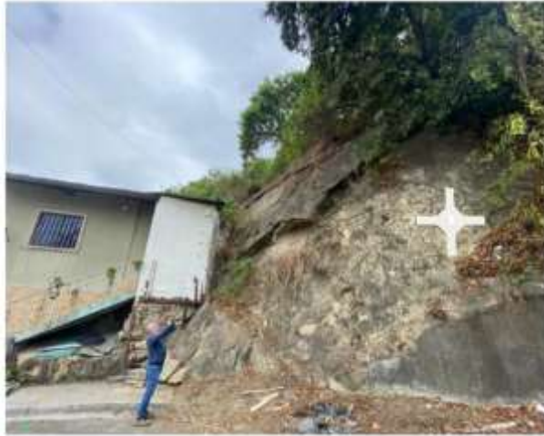
Figura 81. Una cruceta instalada al pie del talud en zona expuesta (zona cerro San Eduardo-Monumental)
