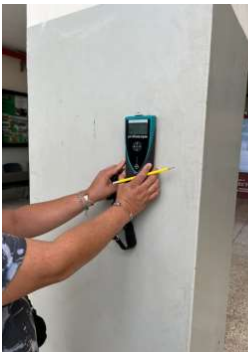
Figura 25 Ensayo en la columna de la fachada frontal. Fuente: Propio.
