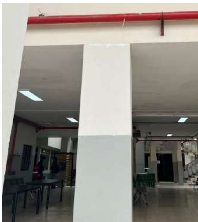
Figura 19 Columna de la Fachada frontal con dimensión de 68x52cm. Fuente: Propio.
