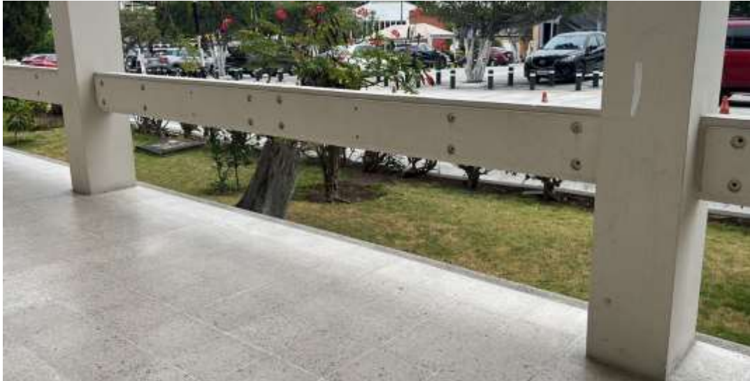
Figura 28 Vigas de la fachada frontal de la facultad de Ingeniería. Fuente. Propio.
