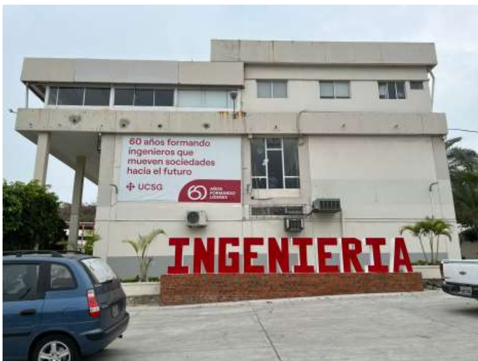
Figura 4 Fachada lateral de la Facultad de Ingeniería de la UCSG. Fuente: Propio, foto tomada el 15/10/2022.
