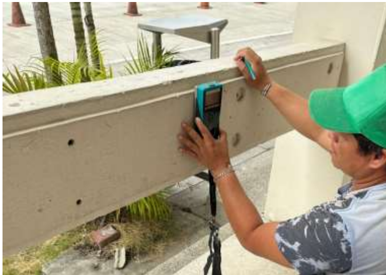
Figura 29 Lectura con Profoscope en vigas. Fuente: Propio.
