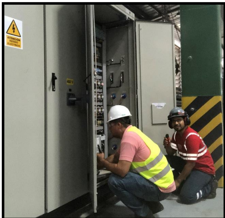
Figura Anexo 2. 4. Conexión de todas las cargas.
