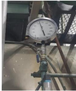
**Figura 2. 11:** Manómetro con sifón tipo R.
