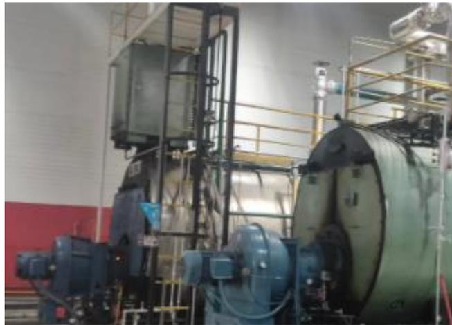
**Figura 2. 6:** Caldera pirotubular de vapor con economizador incorporado.
