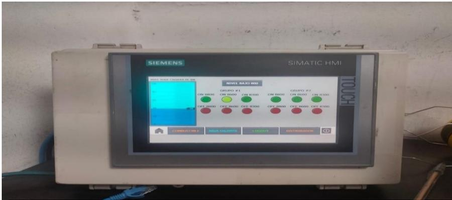
Figura A.1. 3: HMI ubicado en sala de control.
