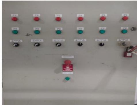
**Figura 3. 36:** Bombas de combustible HMI.
