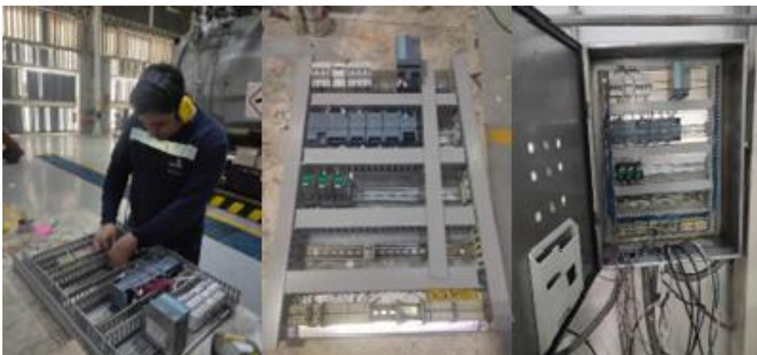
Figura A.1. 2: Armado y montaje del tablero del PLC,
