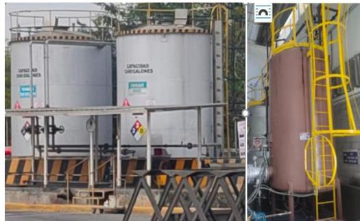
**Figura 3. 32:** Tanques de combustible y tanque diario.
