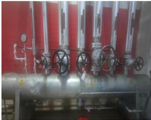
**Figura 3. 38:** Distribuidor de vapor.
