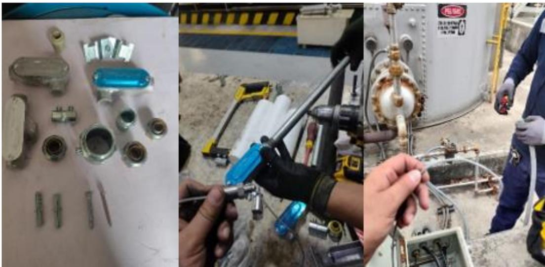
Figura A.1. 5: Montaje de tubería y accesorios.
