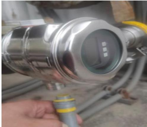
**Figura 3. 31:** Sensor hidrostático con funda sellada.
