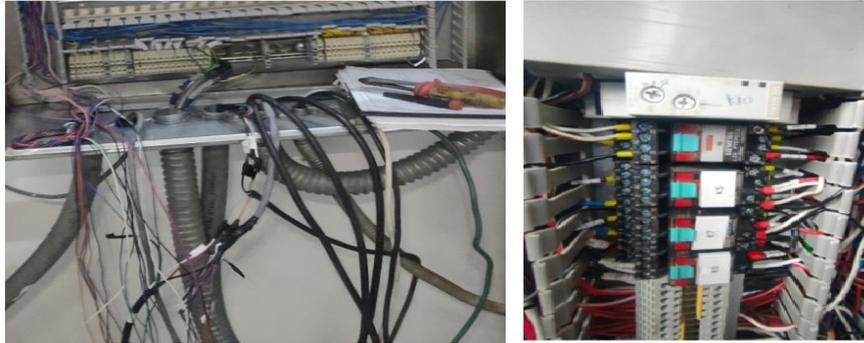
**Figura 3. 25:** Señales desde el tablero de tanques de combustible al PLC.
