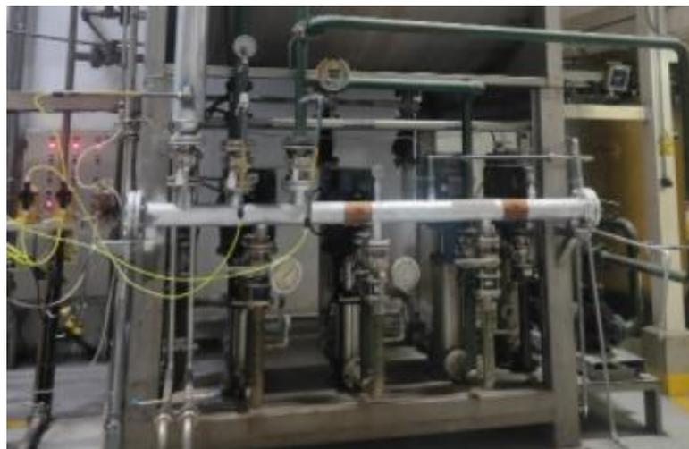
**Figura 2. 15:** Tratamiento de la alimentación de agua a calderas de vapor.
