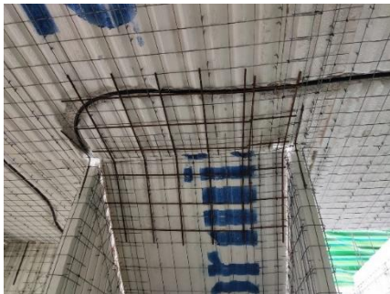
Ilustración 35 Refuerzo para losa. Fuente: Autor, 2023
