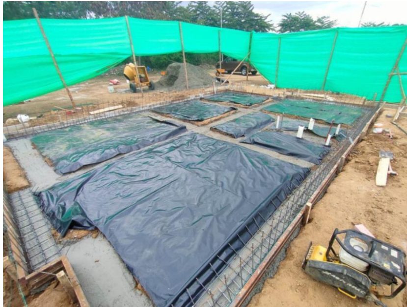
Figura 24 Fundición de riostras en cimentación. (Mendoza, 2022)
