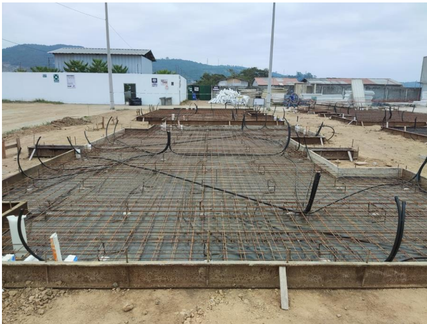
Figura 30 Cimentación Ciudad Santiago Etapa V. Fuente: Autor, 2023
