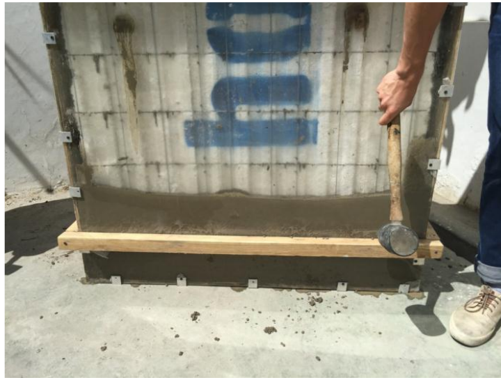
Figura 59 Vibrado manual de mortero. Fuente: Orozco & Puente, 2016
