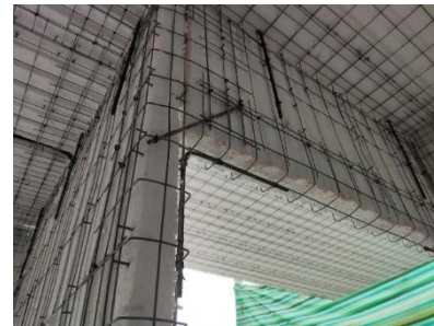
Ilustración 34 Mallas angulares y refuerzo para ventanas. Fuente: Autor, 2023
