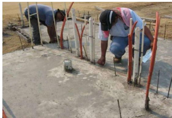
Figura 25 Replanteo para paredes. (Echeverría, 2018)
