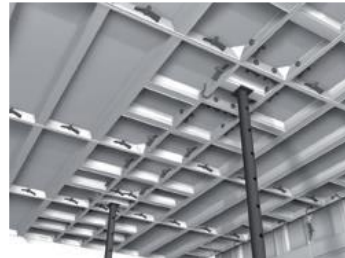
Ilustración 14 Losa de apuntalamiento en uso. (Catálogo Forsa, 2020)
