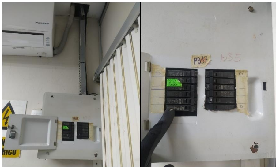
Figura 40 - Instalación de nuevo disyuntor para sistema eléctrico independiente del proyecto
