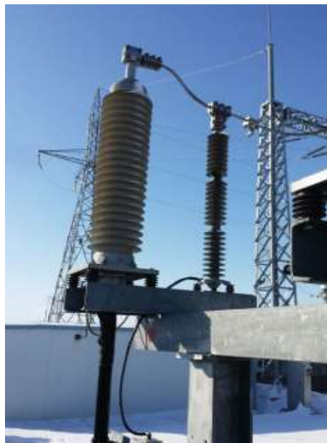
Nota: válvula descargadora automática. Tomado de (Castro, 2021)
