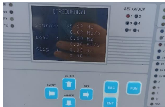
Figura 3.17: Datos de frecuencia del control digital ETR300-R
