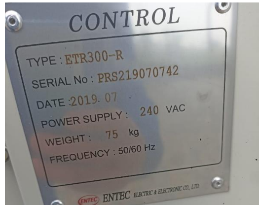
Figura 3.11: Placa técnica de los datos del tablero de control del Reconectador
