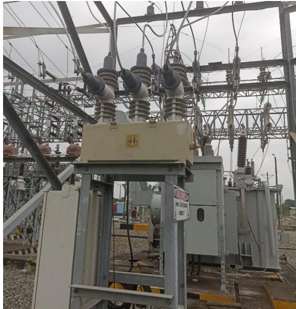
Figura 3.1: Reconector automático aislado sólido del Alimentador Caracol
