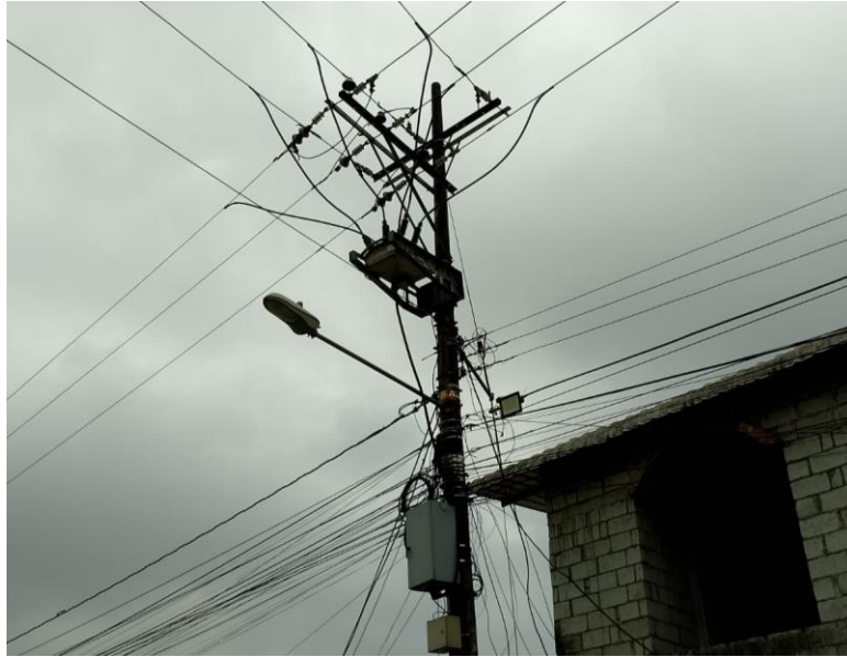
Figura A6: Reconector de Transferencia Caracol - Clementina
