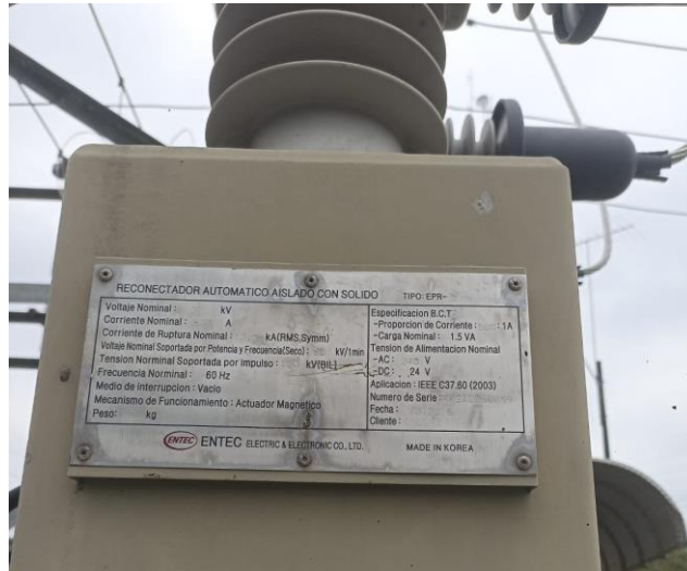
Figura 3.2: Placa técnica de los datos del Reconectador automático aislado sólido del Alimentador Caracol
