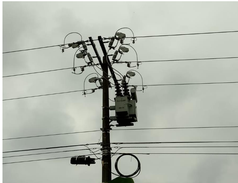
Figura A12: Transformix de las líneas
