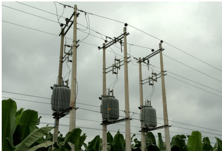
Figura A9: Capacitores de las líneas
