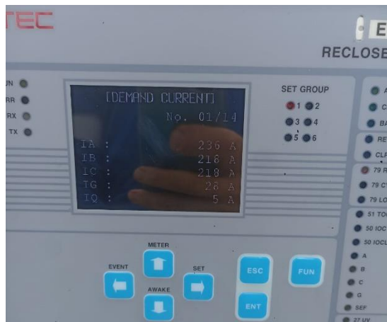
Figura 3.13: Datos de la demanda de corriente del control digital ETR300-R
