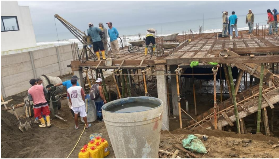
Fig- 25 Fundición Losa de Hormigón.
