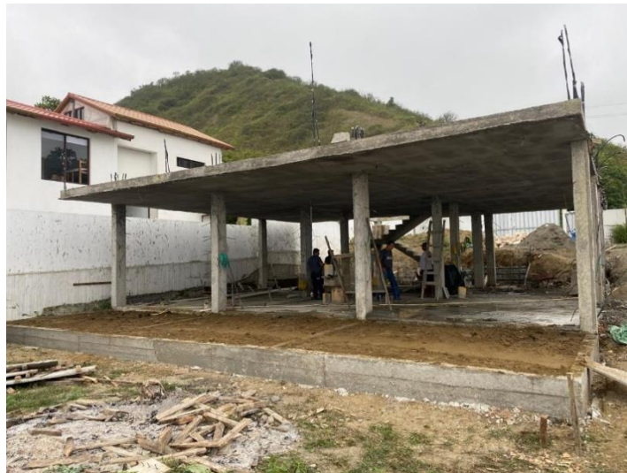
Losa terminada
