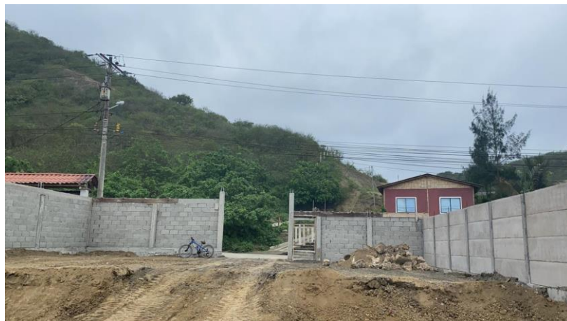
Fig- 2424 Muro de Cerramiento con Elementos Prefabricados y Bloques de Hormigón.
