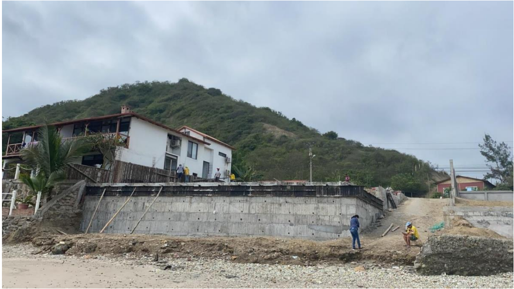
Muro de contención de 153x3m
