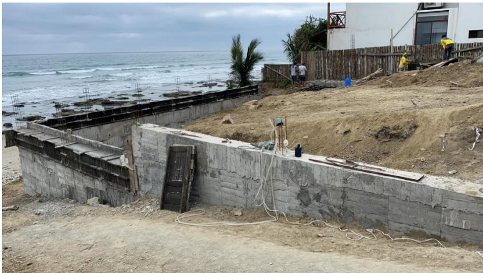
Base de hormigón para muro de cerramiento
