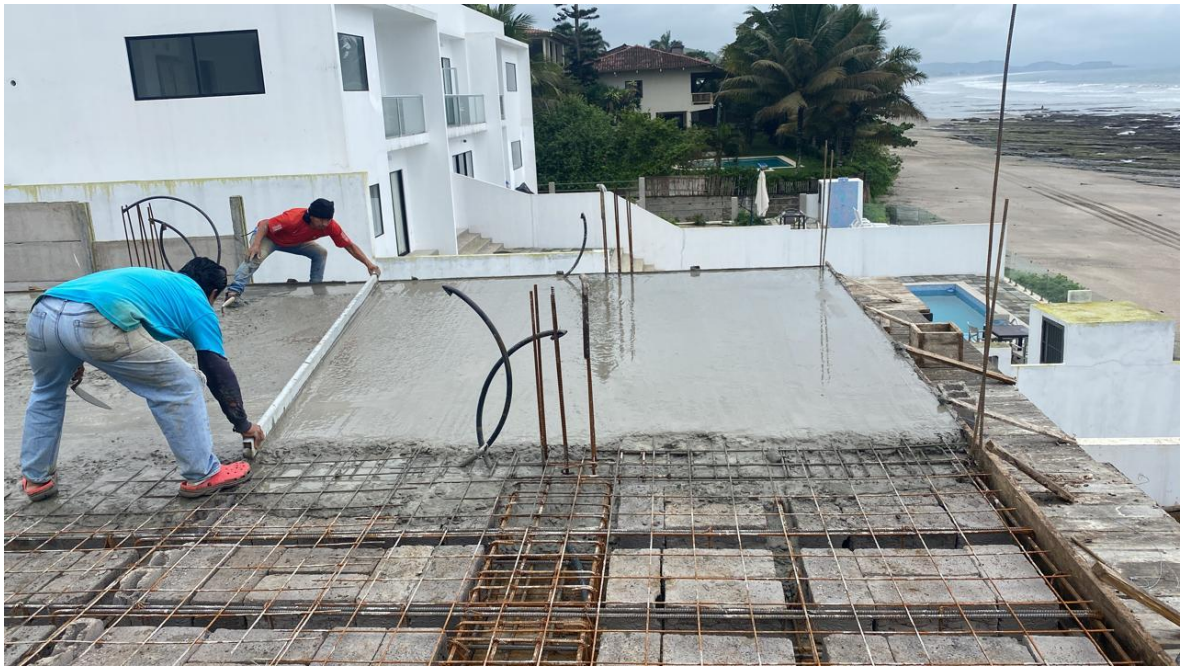
Fundición de losa alivianada con bloques de hormigón
