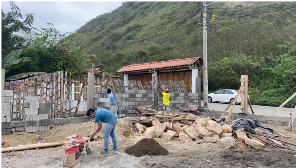
Muro de cerramiento con bloques de hormigón
