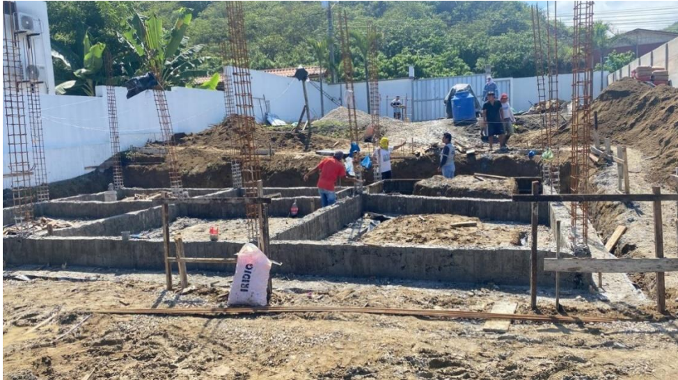
Cimentación de zapatas corridas
