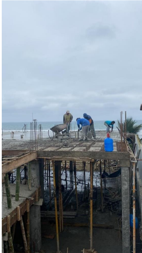
Puntales metálicos para la fundición de losa
