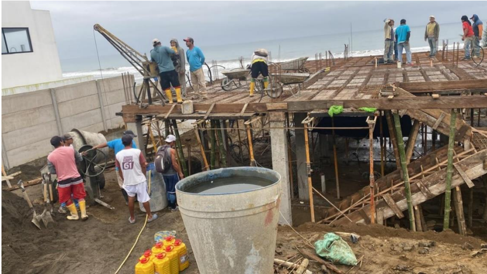
Fundición de losa alivianada
