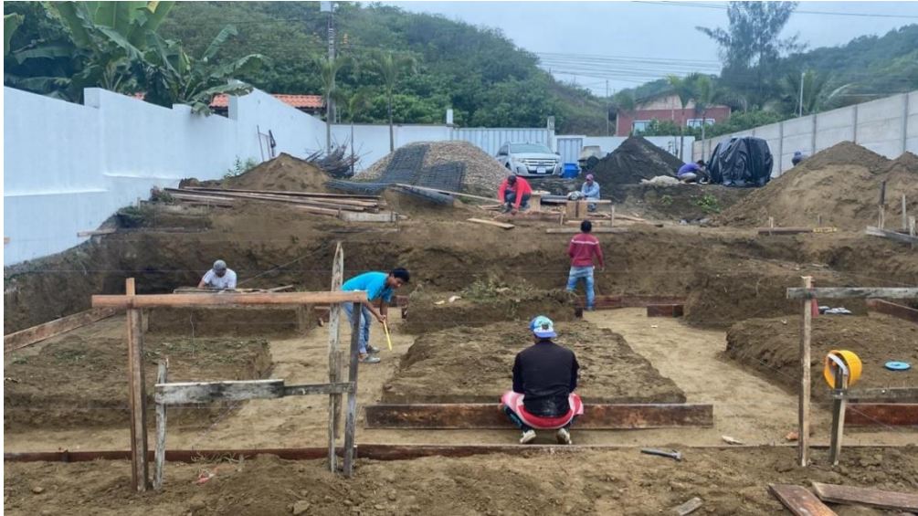
Excavación para cimentación
