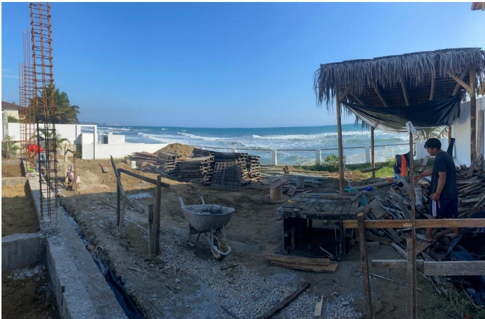
Colocación de columnas
