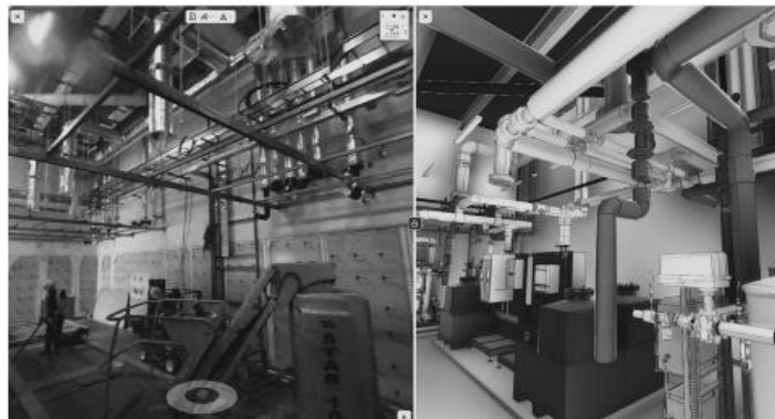
Fig- 18 Fotografía 3D e integración BIM para una comparación tal como está y según lo planeado. Fuente: (González, 2023)
