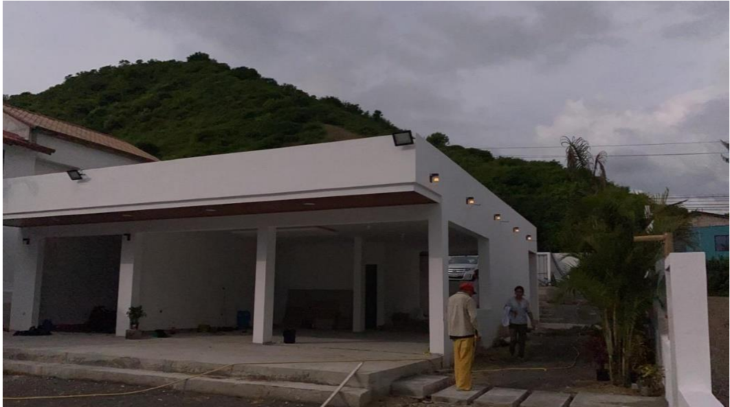
Culminación de pintado de paredes exteriores
