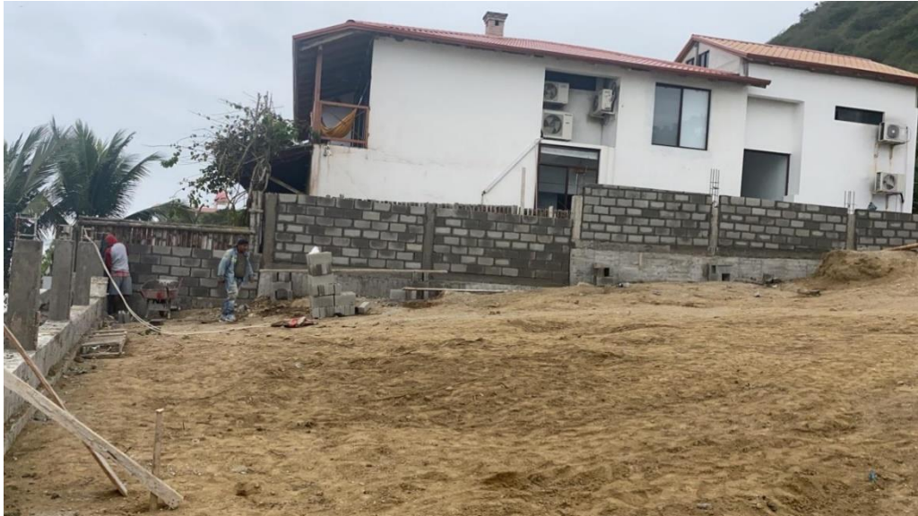
Muro perimetral lado derecho
