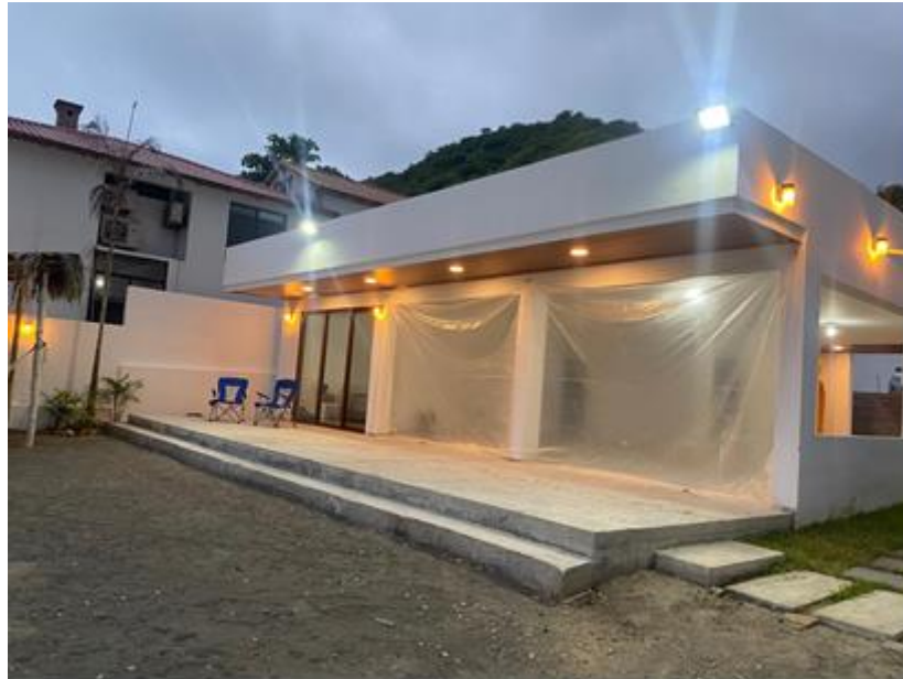
Fig- 26 Pintura en Paredes.
